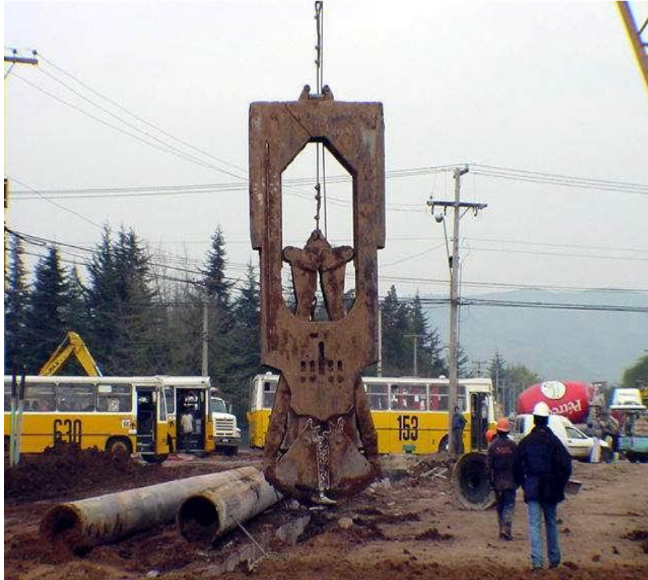
Cuchara bivalva para muros pantalla de concreto armado
