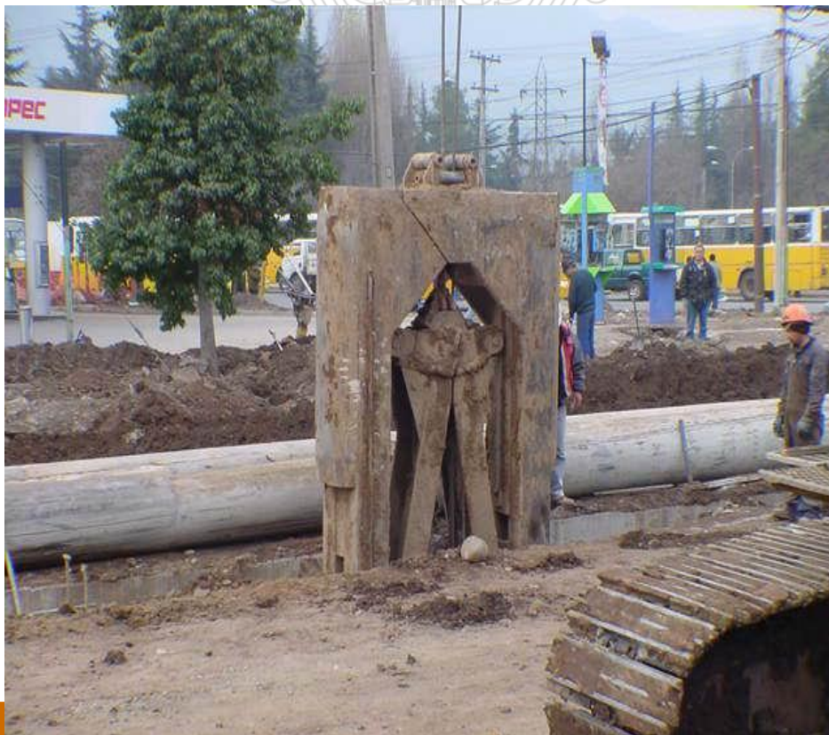
Cuchara bivalva para muros pantalla de concreto armado
