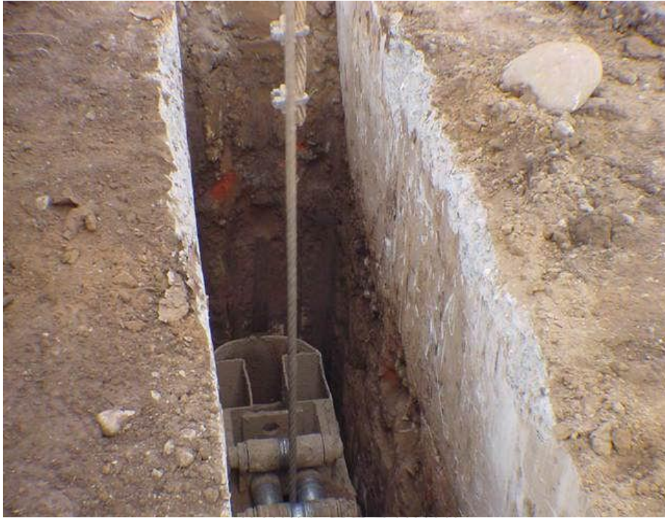
Cuchara bivalva realizando las excavaciones para vaciar muros pantalla
