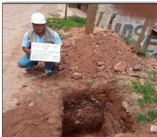
Calicata N° 01 Km 11+154
