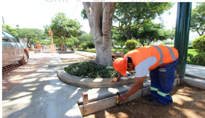
Mejoramiento de la berma central de la Av. Cádiz
