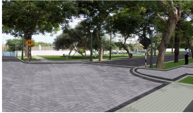
Mantenimiento de bermas en parque del Trabajador Municipal.
