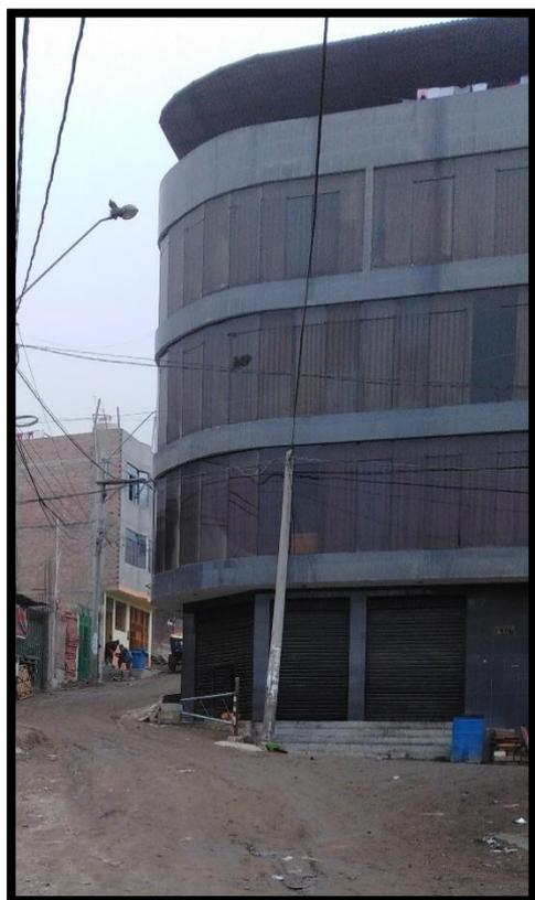
Nota. Fotografía de una vivienda con material predominante de Pared de tipo “Ladrillo”, material predominante de techo de tipo “Ladrillo”, con estado de conservación “bueno”, ubicado en una pendiente de terreno de 0 a 10%, la vivienda cuenta con 5 pisos, con libre de cargas vivas en el techo. Elaboración Propia
