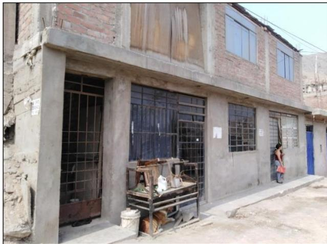
Nota. Fotografía de una vivienda con material predominante de Pared de tipo “Ladrillo”, material predominante de techo de tipo “Ladrillo”, con estado de conservación “regular”, ubicado en una pendiente de terreno de 0 a 10%, la vivienda cuenta con 2 pisos, con libre de cargas vivas en el techo. Elaboración Propia
