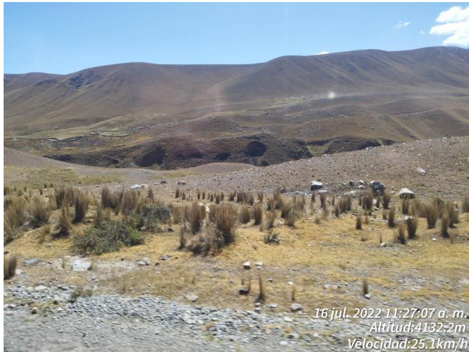
Fotografía 3: Pequeños deslizamientos rotacionales
