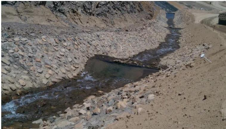
*Nota.* Imagen tomada del canal con pendiente 12% y con barreras de rocas.
