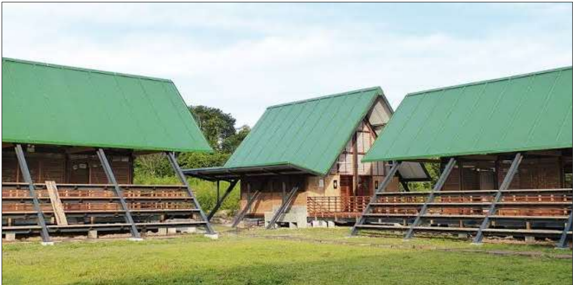
Figura 73. Techo inclinado de calaminón
