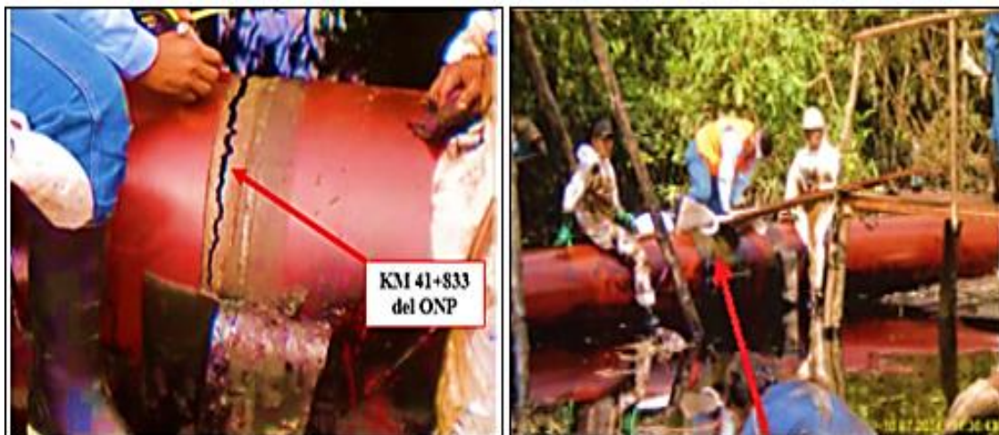
Figura N° 20. Punto donde ocurrió la falla (rajadura) del ONP
