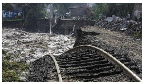
*Figura 30.* En Chalacayo, parte de la línea férrea se encuentra dentro del río y la otra se encuentra dañada y a punto de caer debido a que las bases de la estructura han sido socavadas. (21 marzo 2017)
