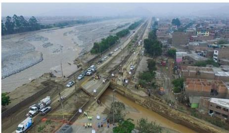
*Figura 15.* Desplazamiento del puente por fuerza destructiva de Huaycoloro.
