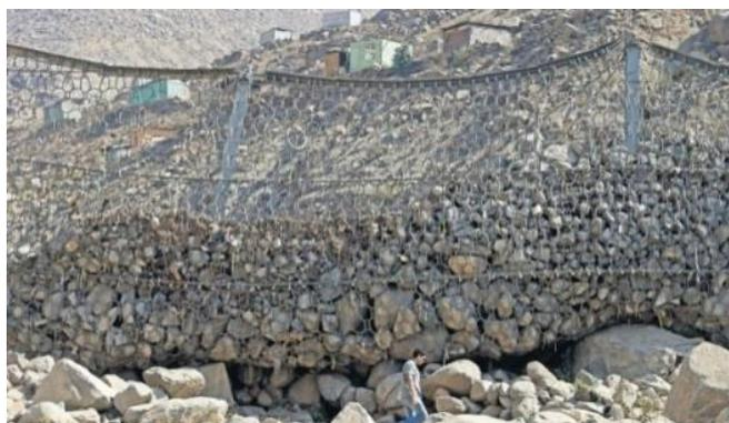
*Figura 6.* Mallas antihuayco empujadas por toneladas de rocas y tierra en Lurigancho-Chosica.
