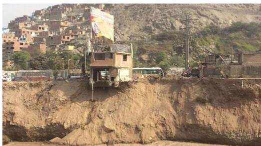
*Figura 34.* Casa ubicada a la altura del cruce de Malecón Checa con Av. Gran Chimú, en SJL, a la orilla del río Rímac a punto de colapsar debido a la inundación. (09 febrero 2017)
