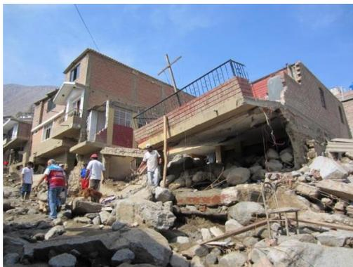
*Figura 5.* Destrucción por erosión lateral del cauce del huayco en quebrada Mariscal Castilla (Chosica)
