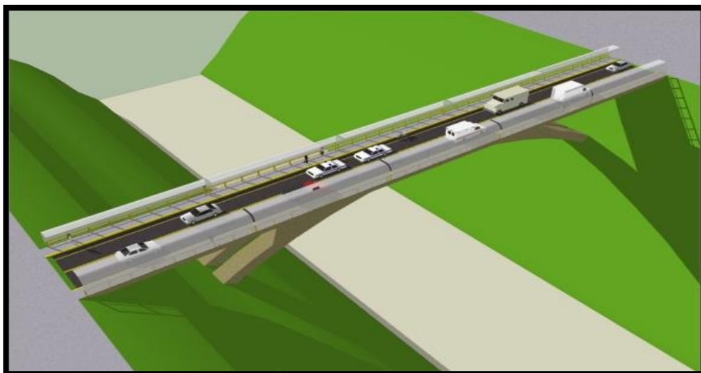
Figura 5 Diseño de puente tipo arco de concreto armado.
