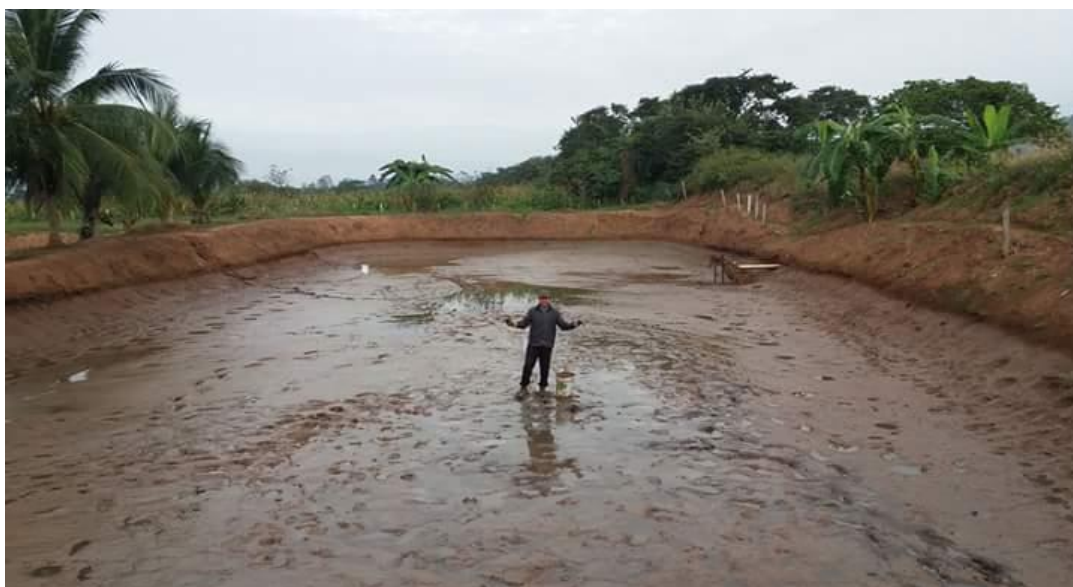
Figura 5. Inicio de llenado de agua a uno de los estanques de cultivo
