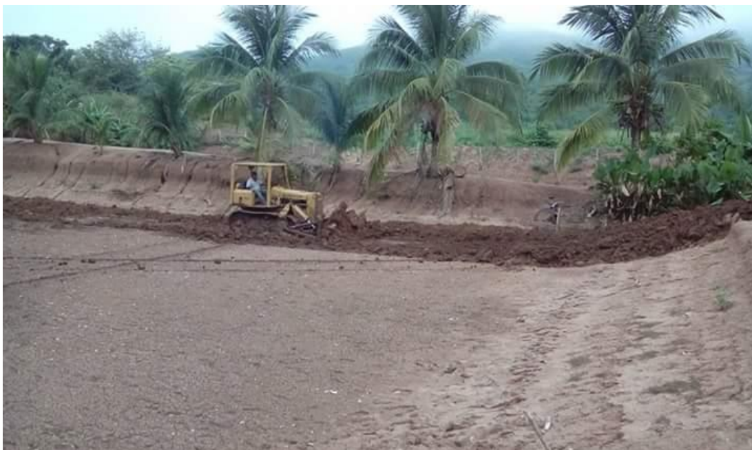
Figura 3. Nivelación del estanque de cultivo utilizando el tractor
