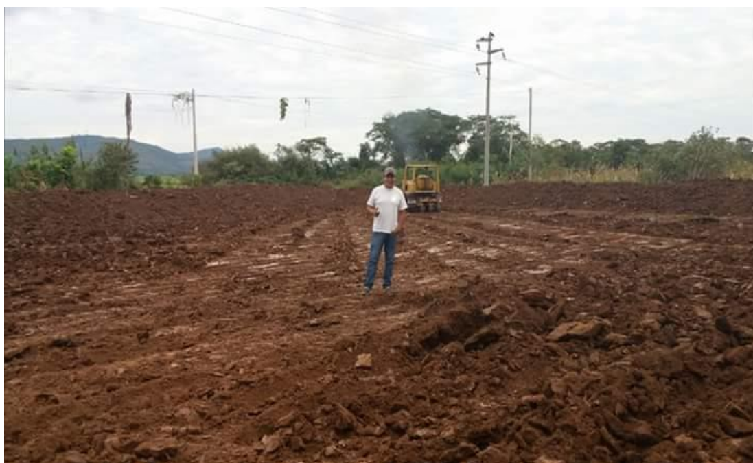
Figura 2. Construcción del estanque de cultivo utilizando tractor
