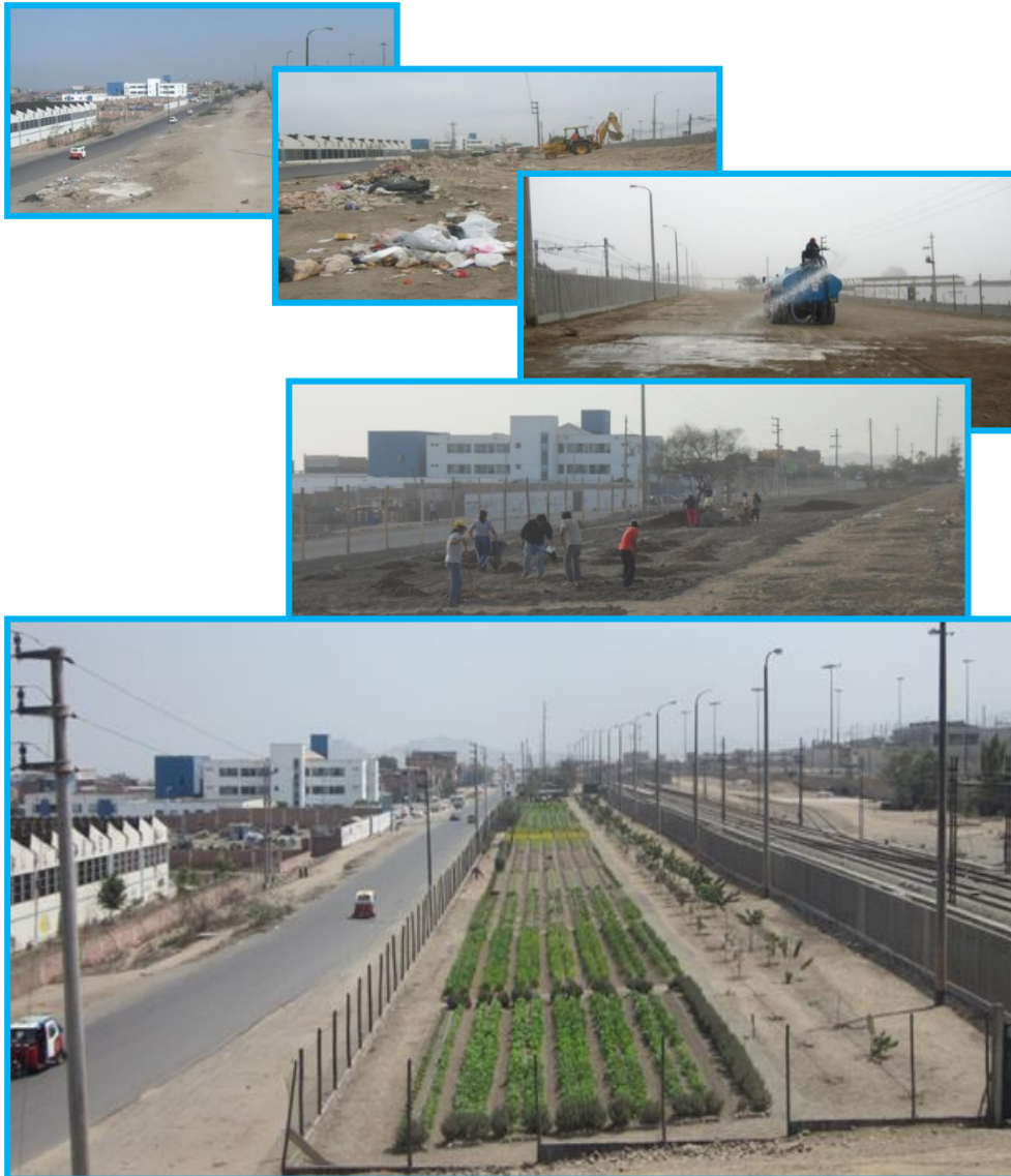
Figura 8: Etapas de la reconversión del terreno baldío Fuente: Elaboración propia.
