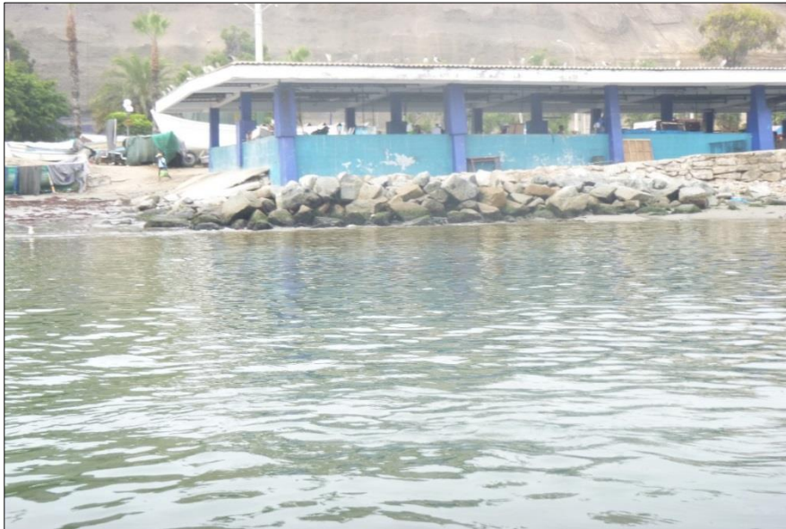
Figura. 12. Vista del DPA donde se tomara el fondo marino en el Punto 2
