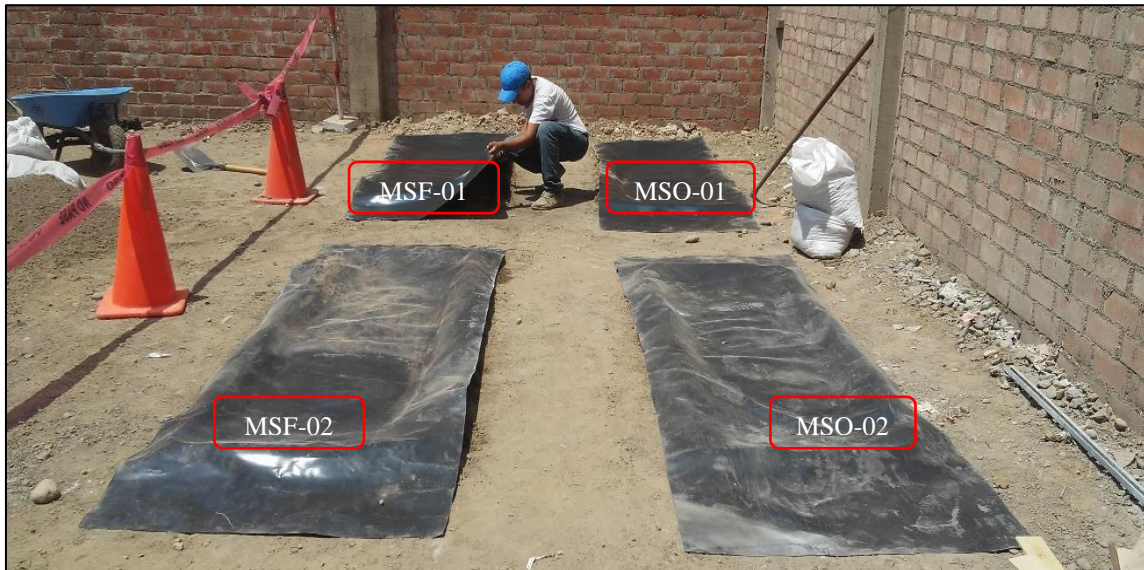
Figura 7. Colocación de geomembranas
