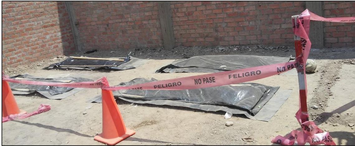
Figura 14. Colocación de cubiertas en las biopilas
