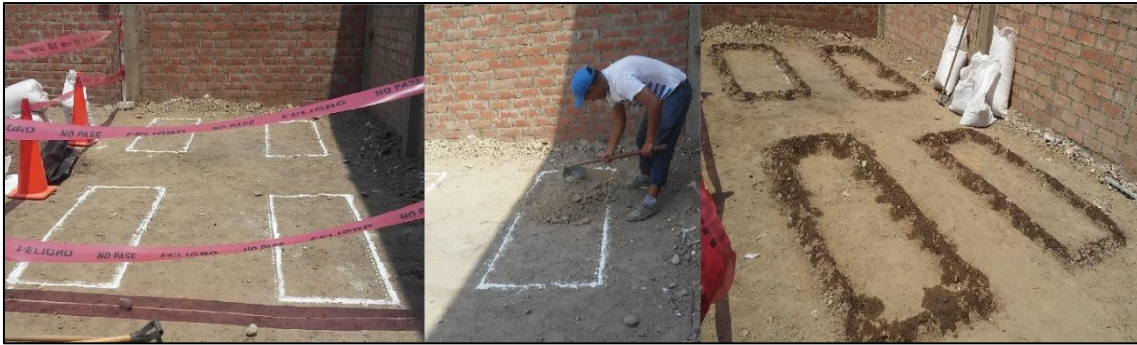
Figura 6. Demarcación de las biopilas y nivelación del terreno
