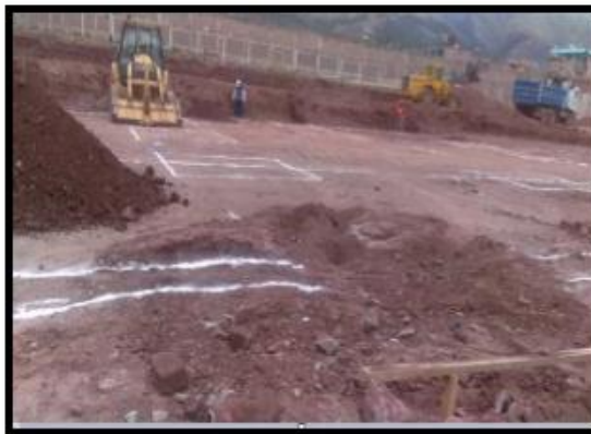
Fotografía 10: Trazo del área de carpintería.
