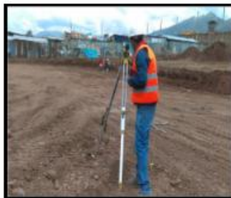
Fotografía 38: Replanteo en área de tejidos con equipo topográfico. .
