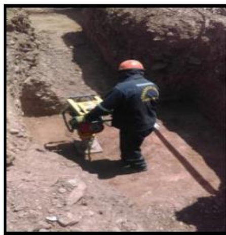
Fotografía 12: compactación en zanjas, zapatas, vigas de conexión con equipos en el área de carpintería.
