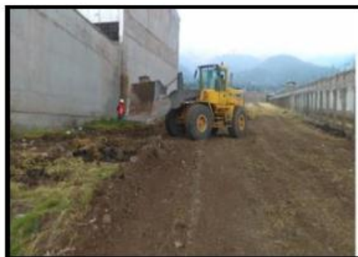
Fotografía 06: Limpieza del área de servicio con maquinaria pesada.
