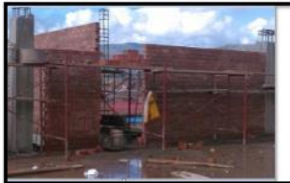
Fotografía 60: Reforzamiento de muros de albañilería con viguetas de confinamiento en el segundo nivel del área de tejidos.
