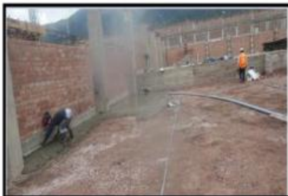
Fotografía 23: Vaceado de falso piso área de carpintería.
