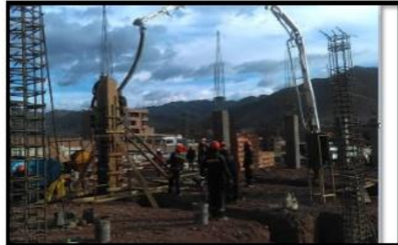
Fotografía 16: Vaceado de columnas, vigas de conexión con mixer en el área de carpintería.
