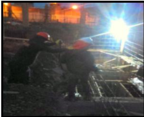
Fotografía 53: trabajos realizados en el turno noche área de tejidos.
