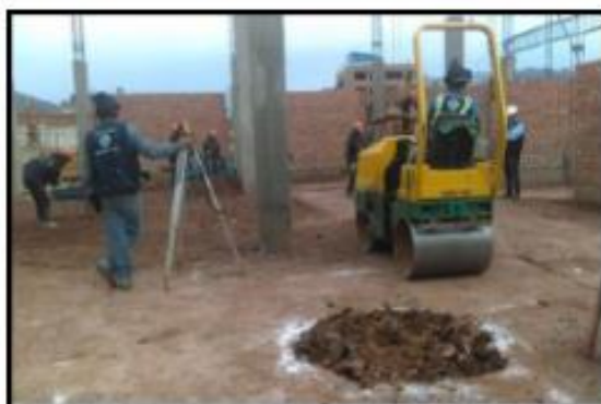
Fotografía 19: Compactación de suelo con rodillo en el área de carpintería.
