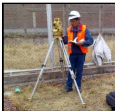
Fotografía 08: Replanteo en área de carpintería con equipo topográfico. .
