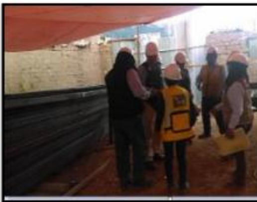
Fotografía 34: Visita al área de estructuras metálicas por el representante INPE.
