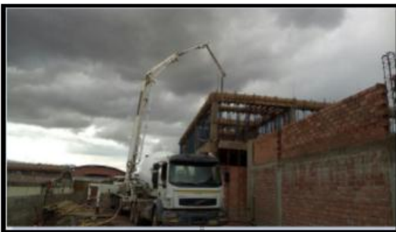
Fotografía 63: Vaceado de vigas segundo piso área de tejidos.
