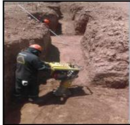
Fotografía 42: compactación en zanjas, zapatas, vigas de conexión con equipos en el área de tejidos
