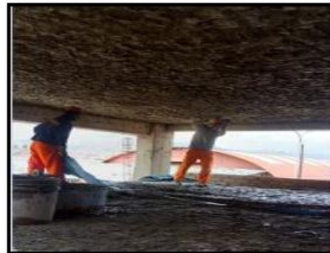
Fotografía 68: Revestimiento de cielo raso.
