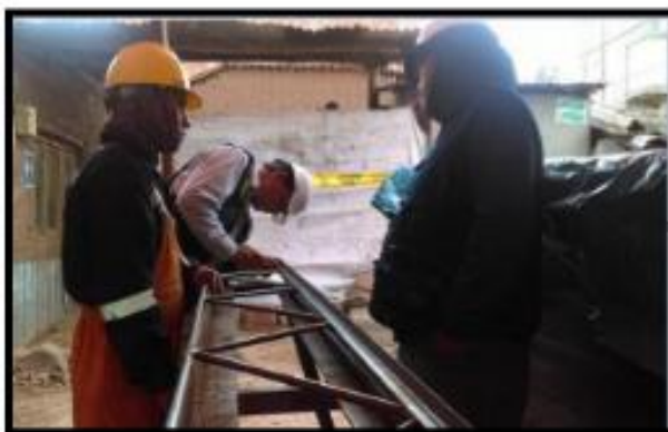
Fotografía 35: Visita al área de estructuras metálicas por el representante INPE.
