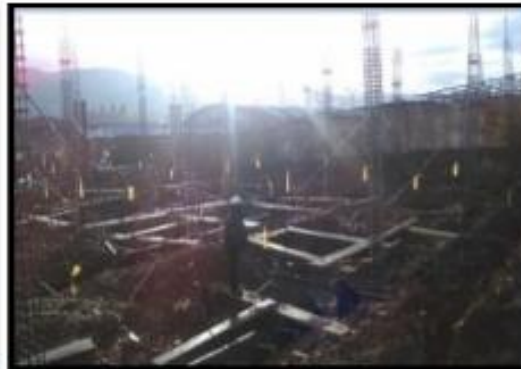
Fotografía 44: Encofrado y desencofrado de zapatas, columnas, vigas de conexión en el área de tejidos
