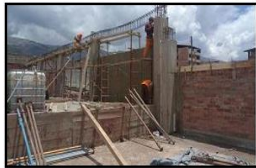
Fotografía 66: Revestimiento de muros en el área de carpintería.
