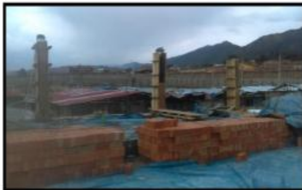
Fotografía 58: Encofrado de columnas en el segundo nivel del área de tejidos.
