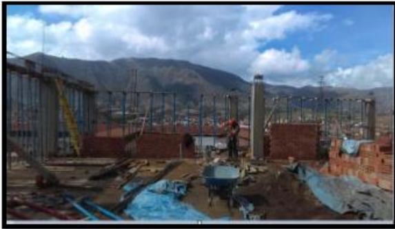
Fotografía 61: Armado de vigas del segundo piso del área de tejidos.
