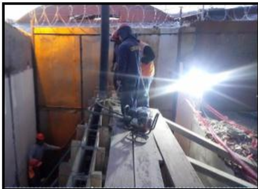
Fotografía 27: vaceado de muro de contención con mixer.
