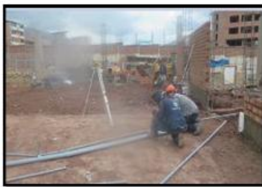
Fotografía 22: instalación de las tuberías para instalaciones sanitarias en el área de carpintería.
