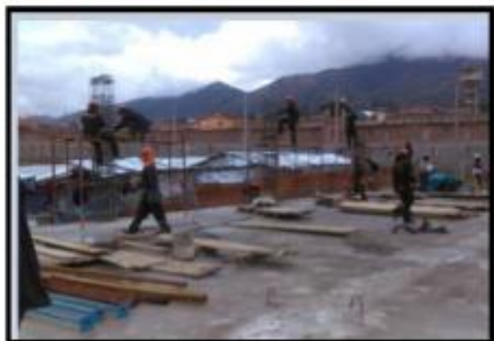
Fotografía 57: Armado de columnas en el segundo nivel del área de tejidos.
