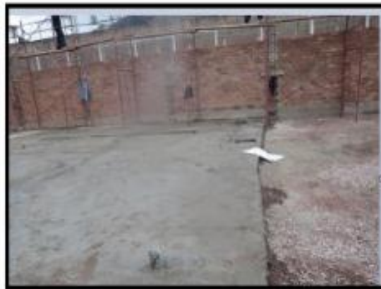
Fotografía 52: Vaceado de falso piso área de tejidos.
