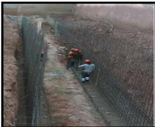
Fotografía 29: Armado y colocación con acero corrugado área de la rampa.
