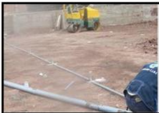
Fotografía 21: instalación de las tuberías para instalaciones eléctricas en el área de carpintería.
