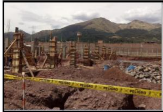
Fotografía 14: Encofrado y desencofrado de zapatas, columnas, vigas de conexión en el área de carpintería.
