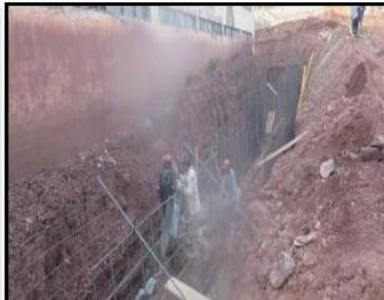
Fotografía 32: Vaceado del área de la rampa.
