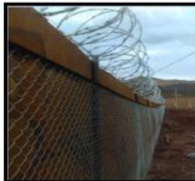
Fotografía 04: Colocación del cerco perimétrico metálico, montaje de concertinas.
