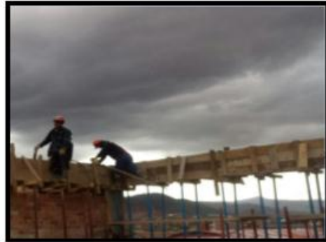
Fotografía 62: Encofrado de vigas en el segundo nivel del área de tejidos.
