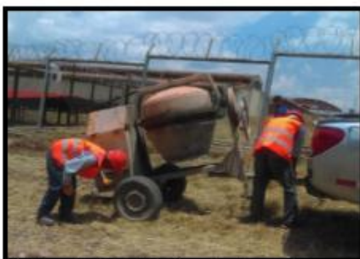
Fotografía 01: Movilización de equipos y maquinarias.
