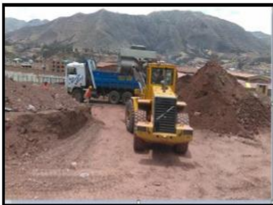
Fotografía 09: Corte de material y disposición del material excedente del área de carpintería.
