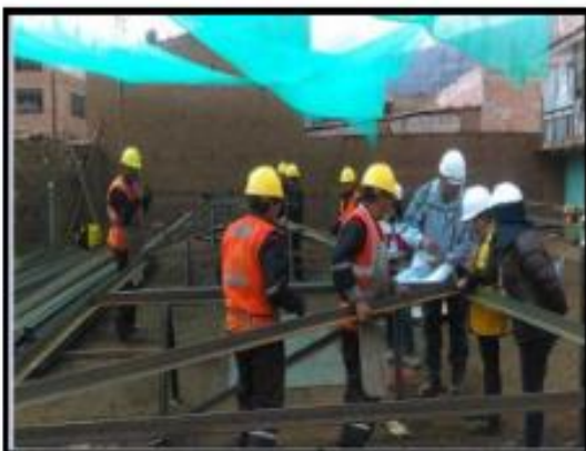
Fotografía 33: Fabricación de tijerales bajo la supervisión del inspector INPE.
