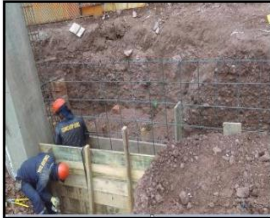
Fotografía 26: zapata de concreto, acero de refuerzo y encofrado de muro de contención.
