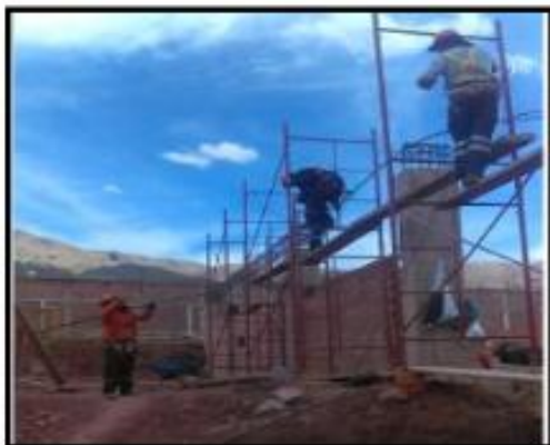
Fotografía 17: Reforzamiento de muros de albañilería con viguetas de confinamiento en el área de carpintería.
