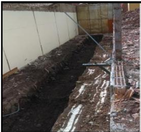
Fotografía 25: trazo y eliminación del material excedente en rampa.
