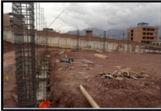
Fotografía 13: Armado y colocación de acero corrugado en columnas, zapatas, vigas de conexión en el área de carpintería.
