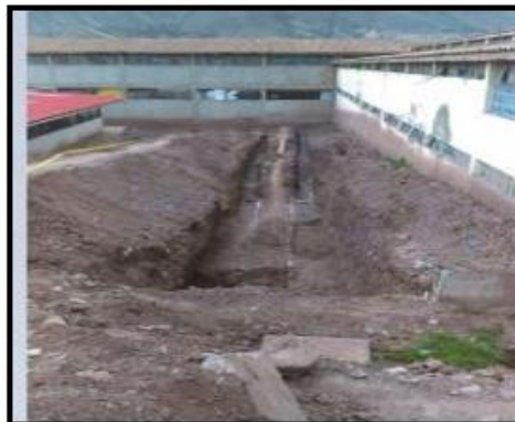
Fotografía 28: trazo y eliminación del material excedente del área de la rampa.
