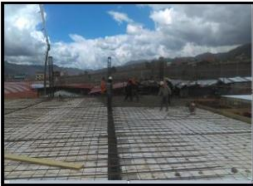
Fotografía 55: Encofrado de losa aligerada con bloques de poliestireno expandido área de
