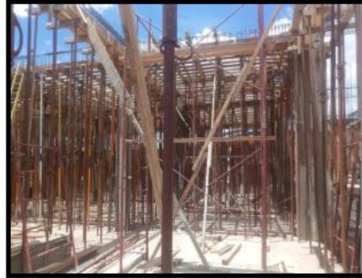
Fotografía 54: Armado con fierro corrugado, vigas y losa aligerada en el área de tejidos.
