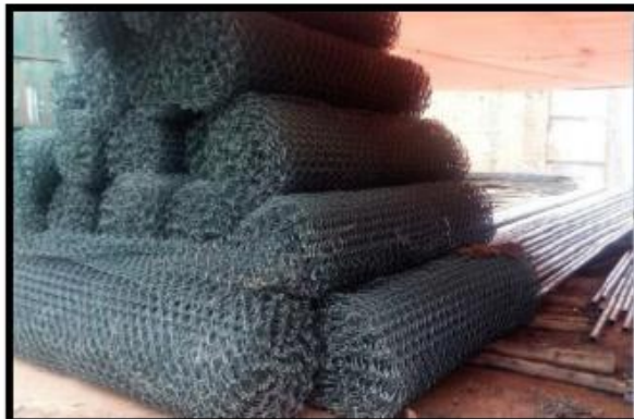
Fotografía 70: Almacenamiento de rollos de mallas plastificada para el cerco.
