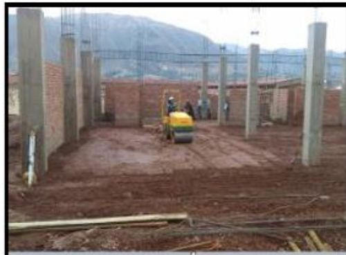
Fotografía 48: Compactación de suelo con rodillo en el área de tejidos
