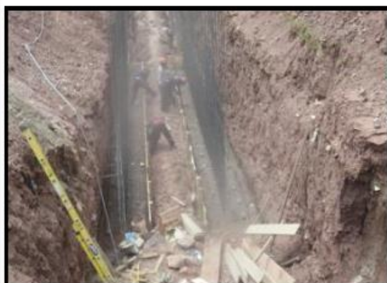
Fotografía 30: Encofrado del área de la rampa.
