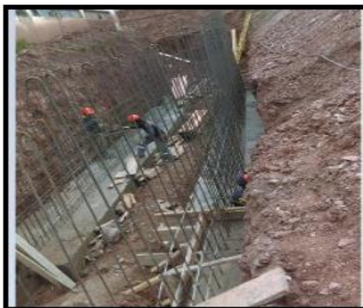
Fotografía 31: Vaceado del área de la rampa.
