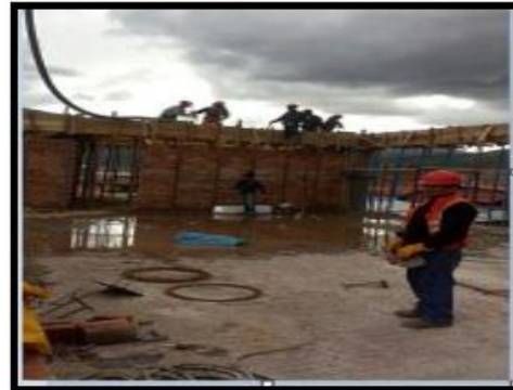
Fotografía 64: Vaceado de vigas segundo piso área de tejidos.
