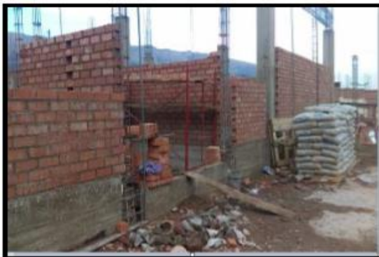
Fotografía 47: Reforzamiento de muros de albañilería con viguetas de confinamiento en el área de tejidos.
