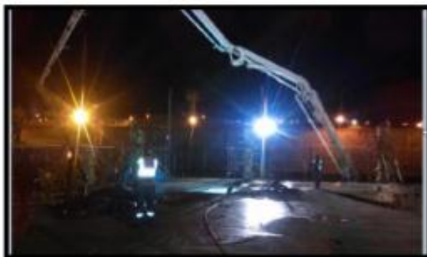
Fotografía 59: Vaceado de columnas en el segundo nivel del área de tejidos.
