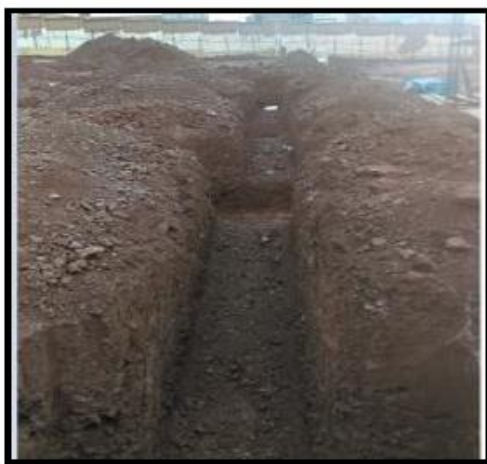
Fotografía 11: Zanjado a mano en terreno normal en el área de carpintería.
