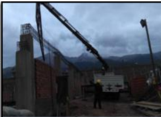
Fotografía 36: Traslado de tijerales al área del servicio.
