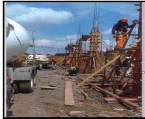
Fotografía 46: Vaceado de columnas, vigas de conexión con mixer en el área de tejidos.
