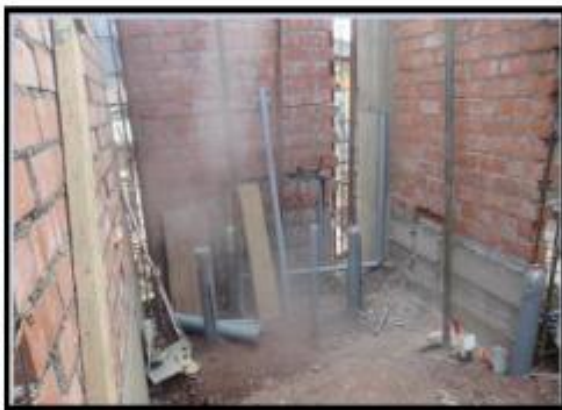
Fotografía 51: instalación de las tuberías para instalaciones sanitarias en el área de tejidos.
