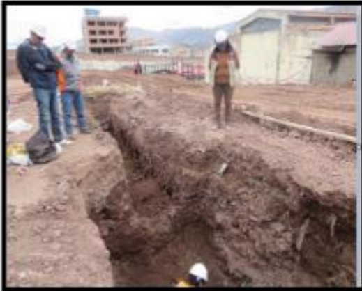
Fotografía 41: Zanjado a mano en terreno normal en el área de tejidos.
