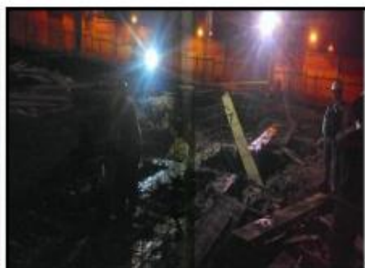
Fotografía 24: trabajos realizados en el turno noche en el área de carpintería.
