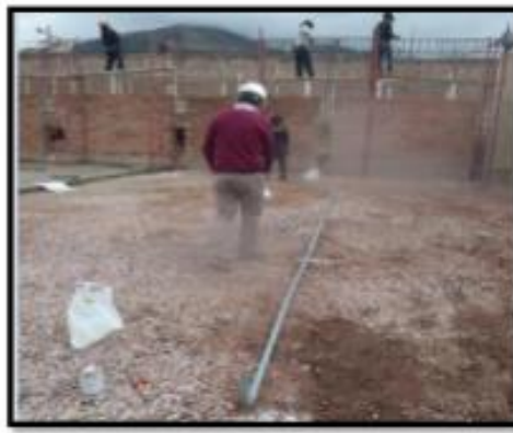
Fotografía 50: instalación de las tuberías para instalaciones eléctricas en el área de tejidos.
