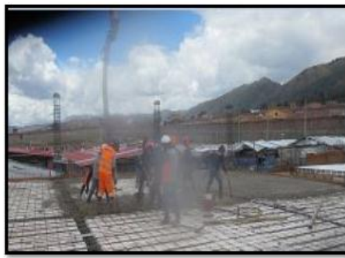
Fotografía 56: Vaceado de losa aligerada con mixer en el área de tejidos
