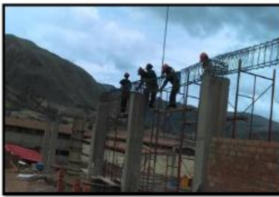
Fotografía 18: Armado con fierro corrugado, vigas en el área de carpintería.
