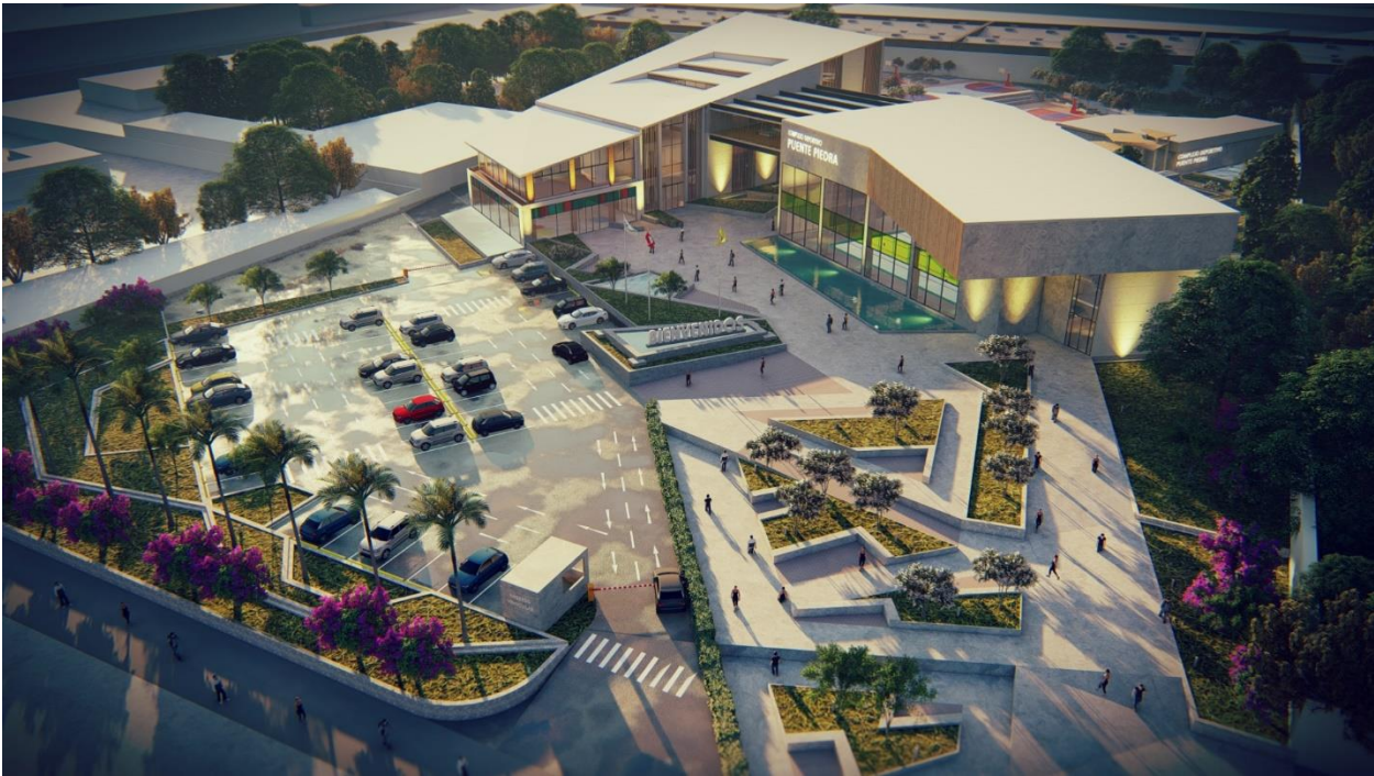
Figura 41. Vista general del ingreso principal Fuente: Elaboración Propia
