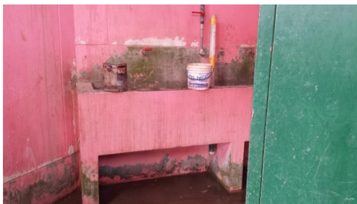
Figura 5 : Servicios higiénicos del Complejo
