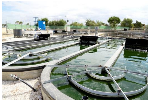
Figura 4: Planta de tratamiento de aguas residuales con microalgas
