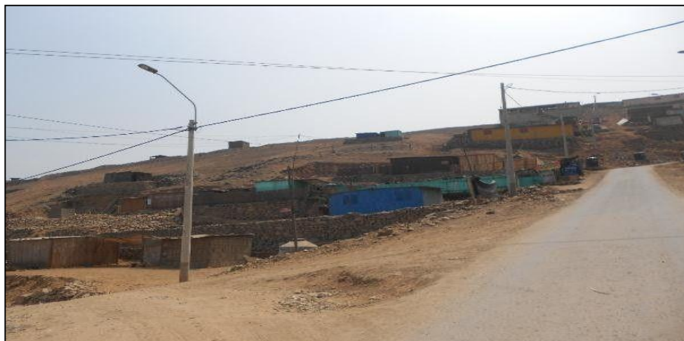
Foto N° 10: Las viviendas del Sector San Agustín presentan un estado de conservación regular
