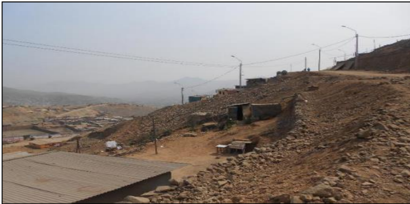
Foto N° 07: Pistas sin muro de contención
