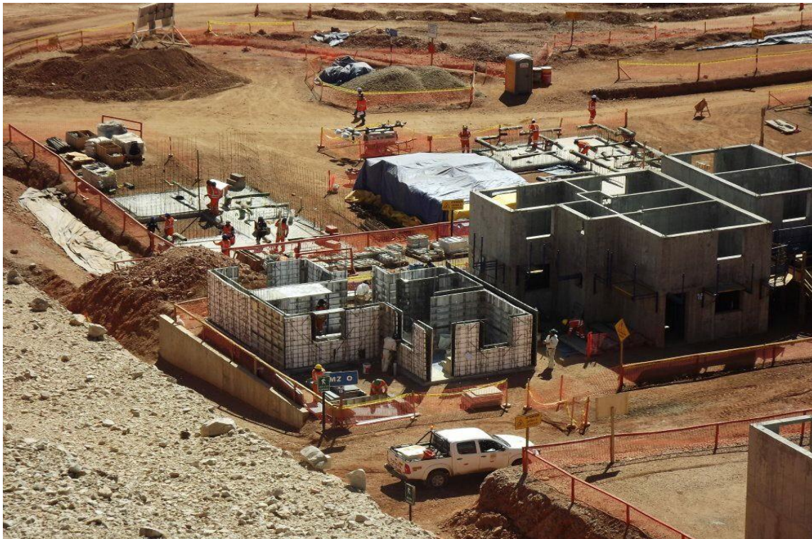
Habilitación de Acero y Sistema Acústico para Viviendas
