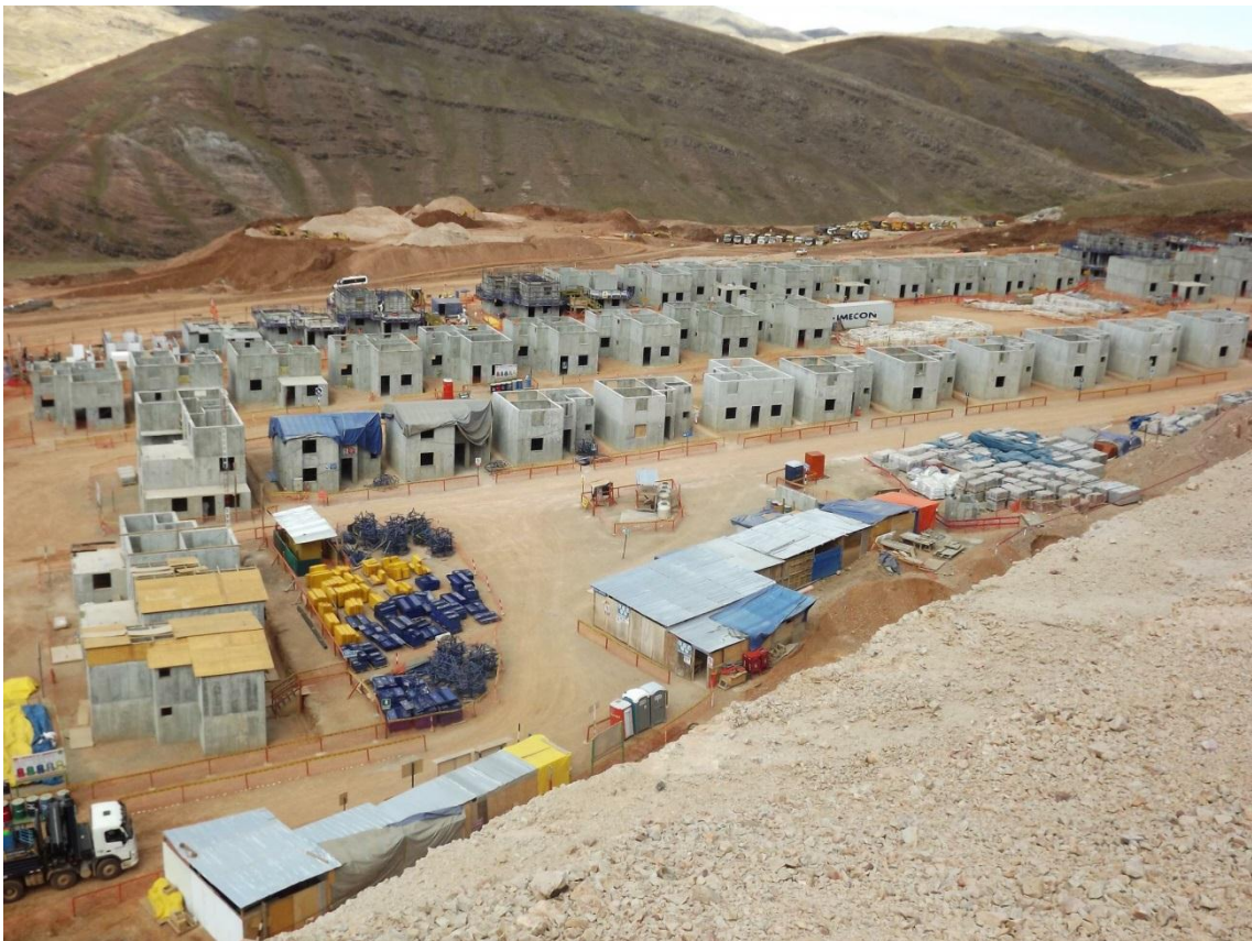
Desencofrado de elementos Verticales.
