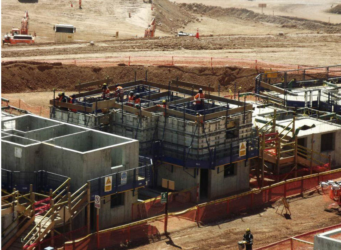
Encofrado de placas con sistema acústico
