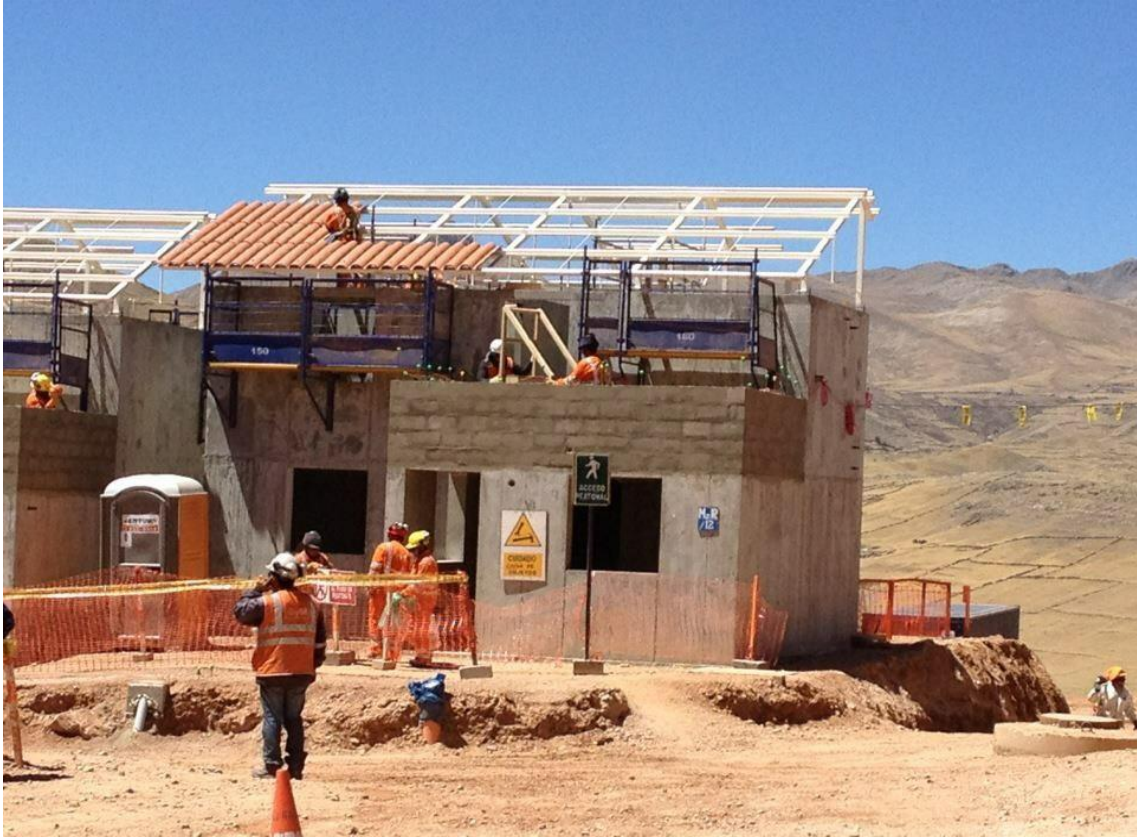
Montaje de estructura metálica y colocación de teja andina
