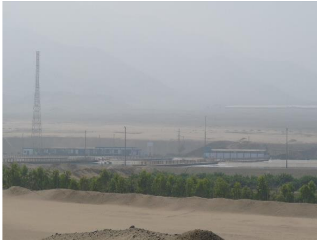
Figura 34. Vista desde el terreno hacia la planta de tratamiento de Sedapal
