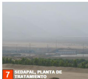
Figura 7. Sedapal. Planta de Tratamiento.
