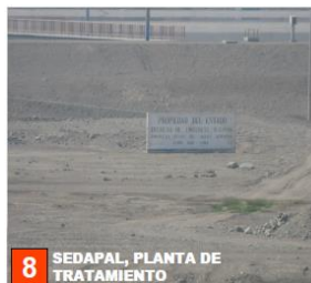
Figura 8. Sedapal. Planta de Tratamiento.
