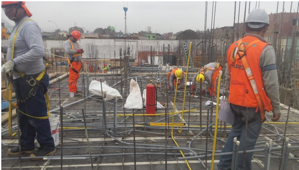
Figura 28 Colocación de tuberías de IISS, GAS, IIEE y Comunicaciones en losa de techos con un espesor de 10cm.
