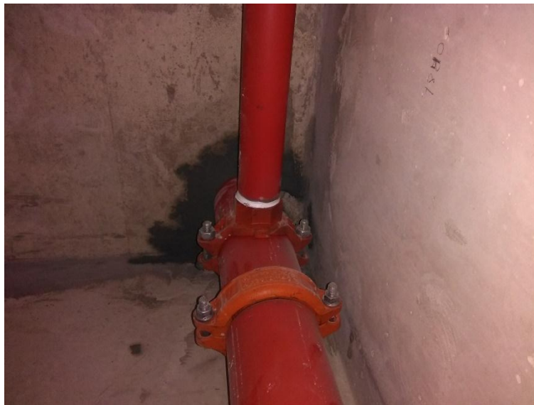
Figura 27 Resane en fondo de escalera para el pase de tuberías de montante de ACI
