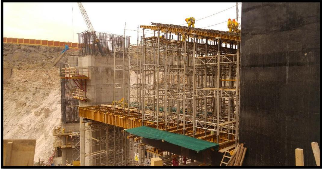
Plataforma Plate Girder ya colocada y encima las torres que soportaran la viga cajón.
