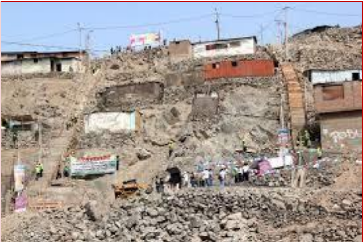
Imagen 4: Vista de los asentamientos humanos en SJL-2
