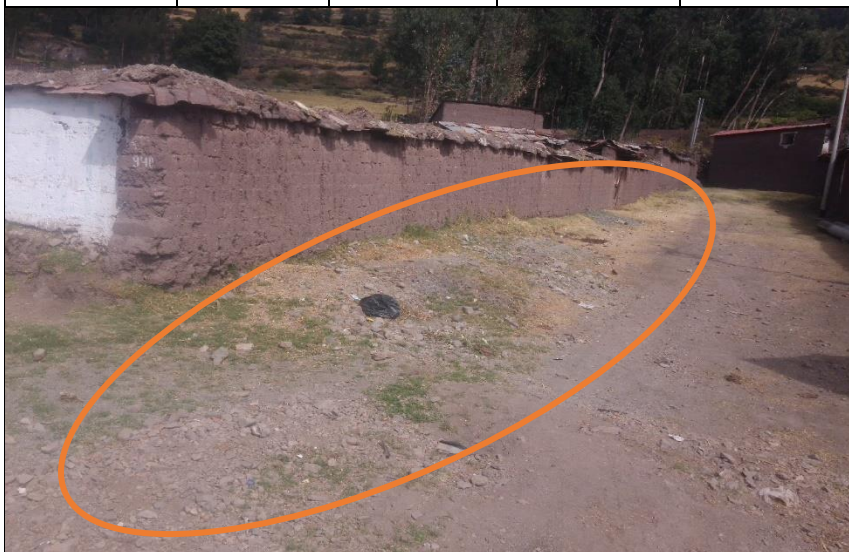
Ubicación del punto crítico la calle Comercio, donde se dispone material constituido por escombros y domésticos.
