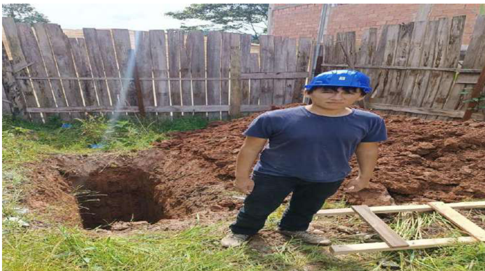
Excavación de calicatas
