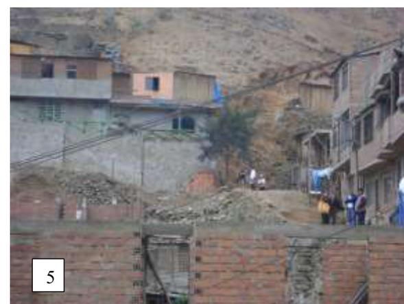
*Nota.* En la figura 1 se visualizan rocas de gran diámetro en zona de seguridad ante sismos; en la figura 2 se identifican cortes de talud inadecuados; en la figura 3 se identifica proceso de socavación en la base del muro de contención; figura 4 pozo de desagüe en mal y por último en la figura 5 se identifica desprendimiento de masas por corte de talud inadecuado.
