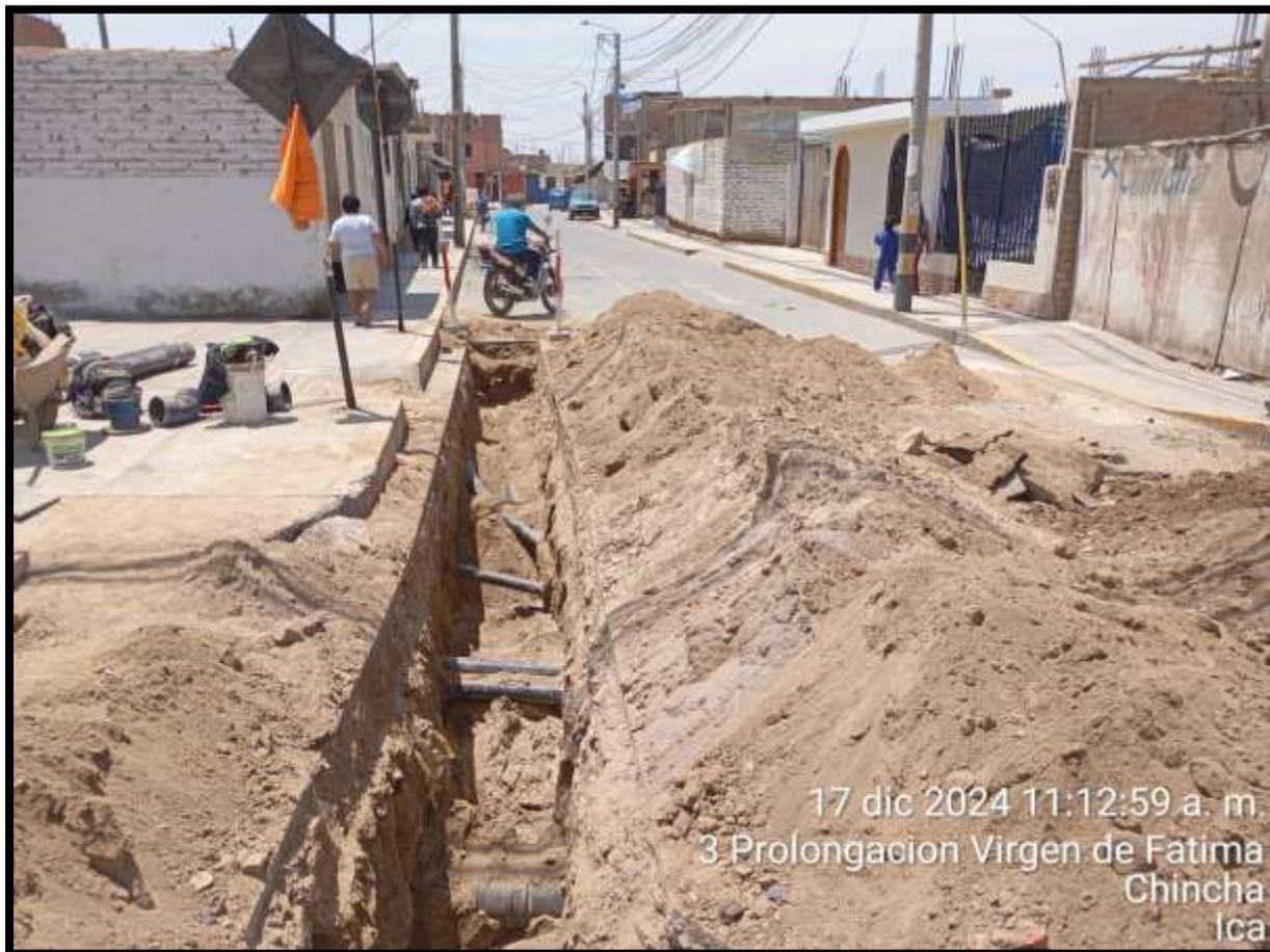
Anexo B: Instalación de red de agua potable proyectada, vista de interferencias encontradas a lo largo de la excavación.
