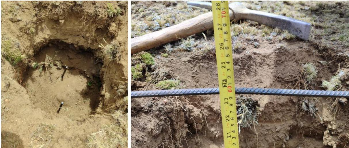
*Nota.* Se dispuso un agujero de 60 cm de profundidad y 40 cm de lado con 2 fierros corrugados con una distancia de 30 cm entre sí para construir el pilar de concreto.
