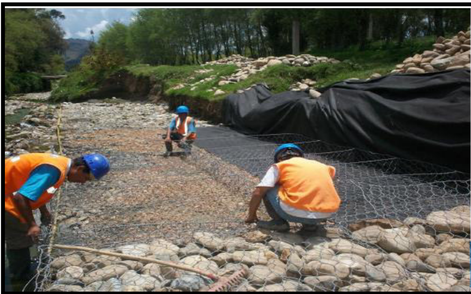
Figura 6 Armado de gaviones tipo colchon
