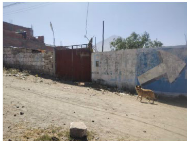
Foto fachada Lat: -16.315068875108 Lng: -71.528121335425
