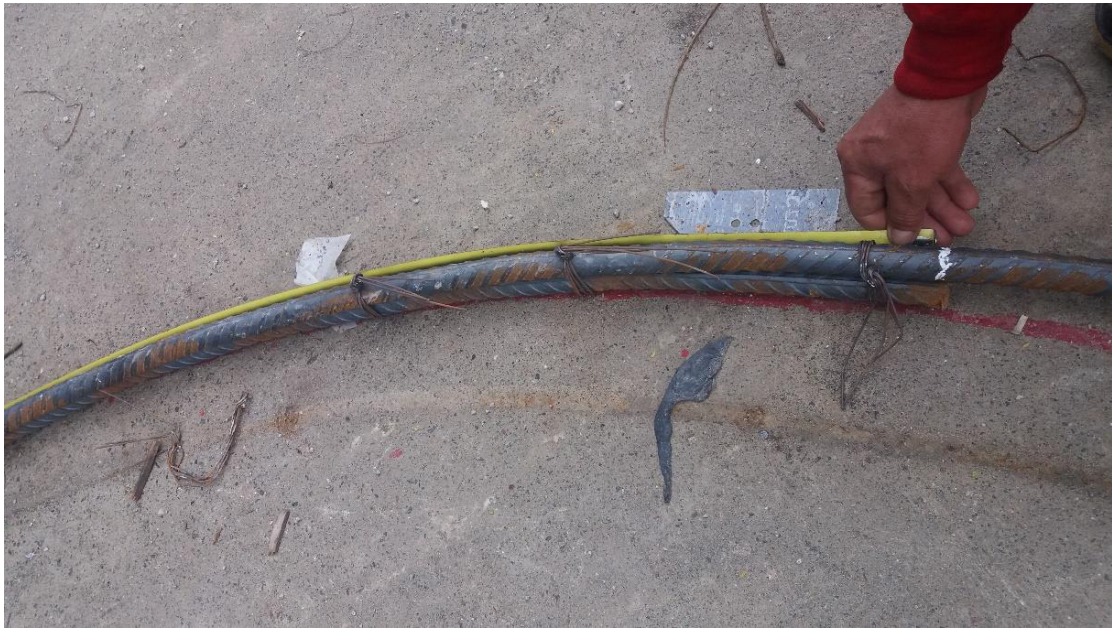
Figura 28 Verificación de Longitud de Traslape Tras Habilitado
