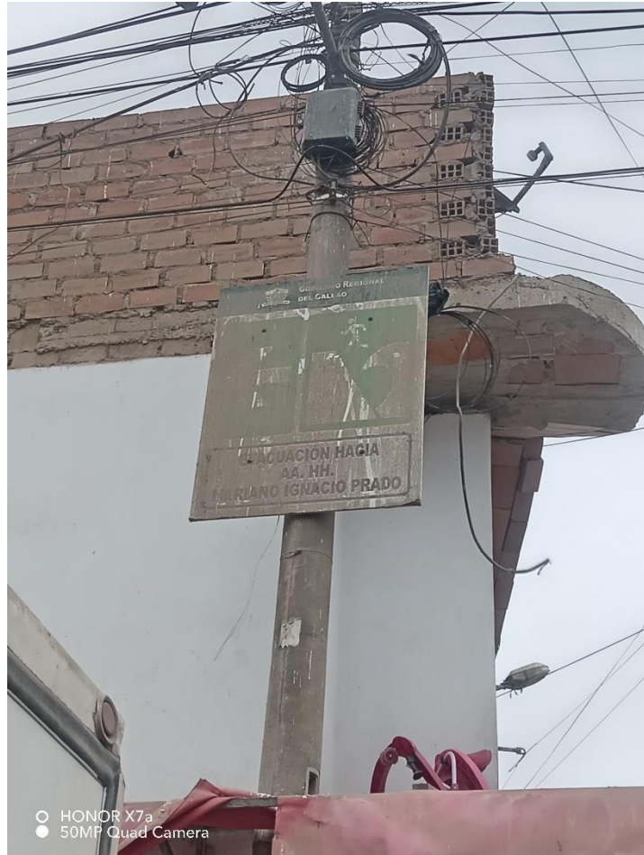
Señalización de ruta de evacuación casi no visible por falta de mantenimiento
