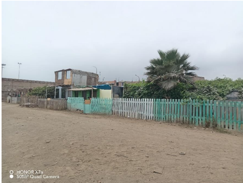
Frontis Izquierdo de la Mz A2 se muestra lotes 6 al 9 de material precario y en mal estado de conservación.
