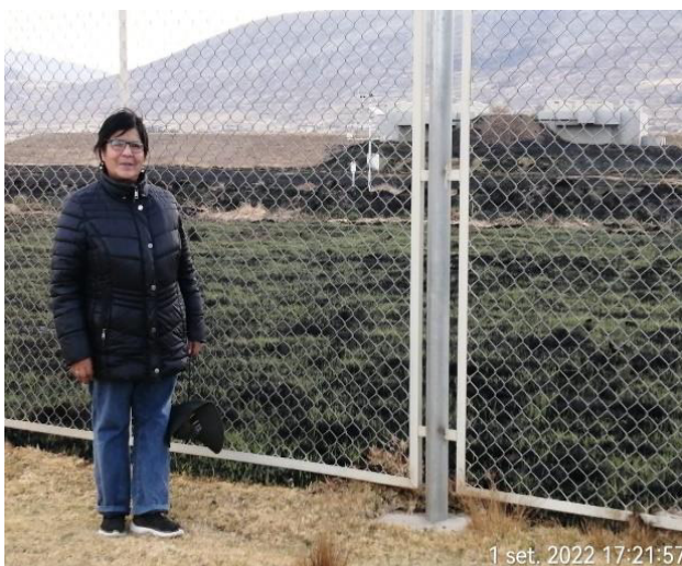
Laguna de Oxidación de Aguas Residuales
