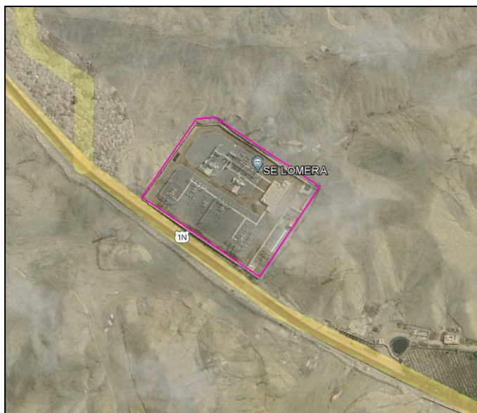
Perímetro de la subestación lomera
