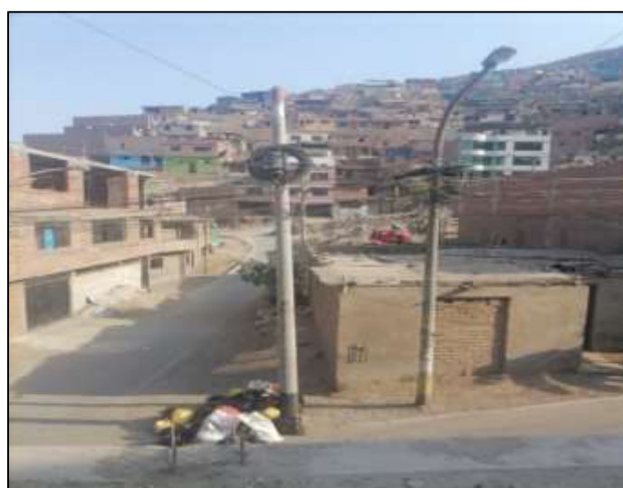
Fotografía 5 Viviendas ubicadas en la parte baja
