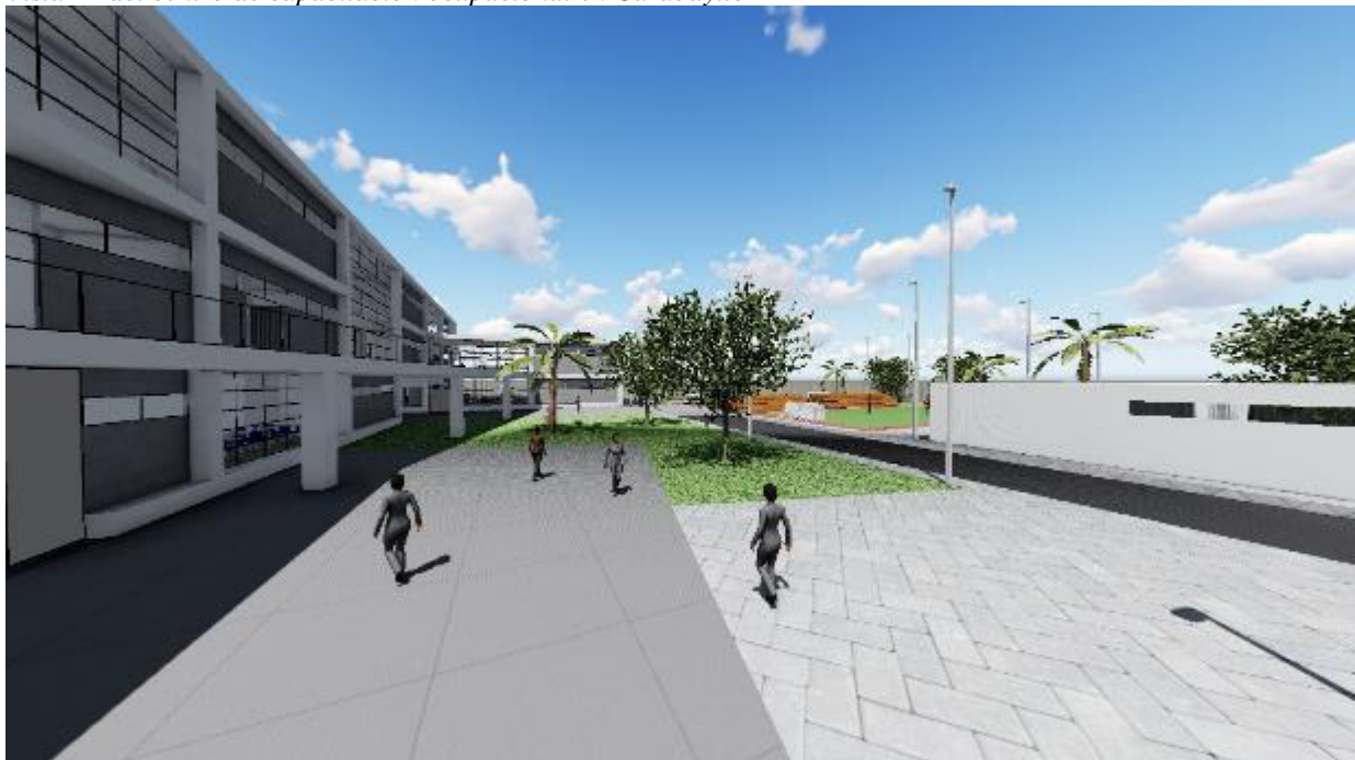
Figura 88: Vista 11 del centro de capacitación ocupacional en Carabayllo
