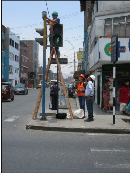
Fotografía 1. Portatubo pasivo instalado en la avenida Las Flores.
