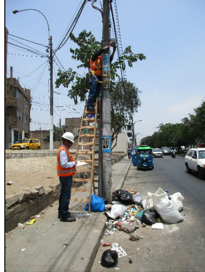
Fotografía 2. Portatubo pasivo instalado en la avenida Las Flores.
