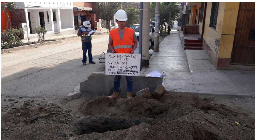
Ilustración 25. Calicata para estudio de suelos para ejecución de Método Cracking.
