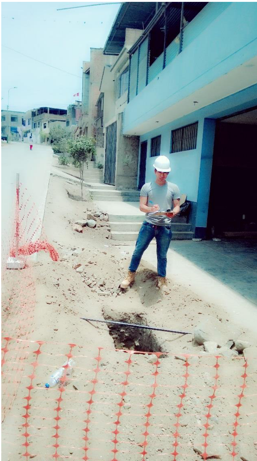
Ilustración 9. Apertura de ventanas para el Método Cracking
