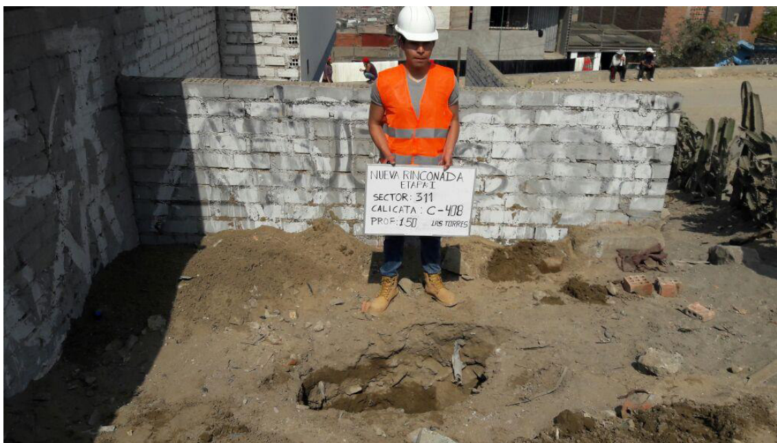
Ilustración 10. Calicata para Estudio de Suelos para Ejecución de Método Cracking.
