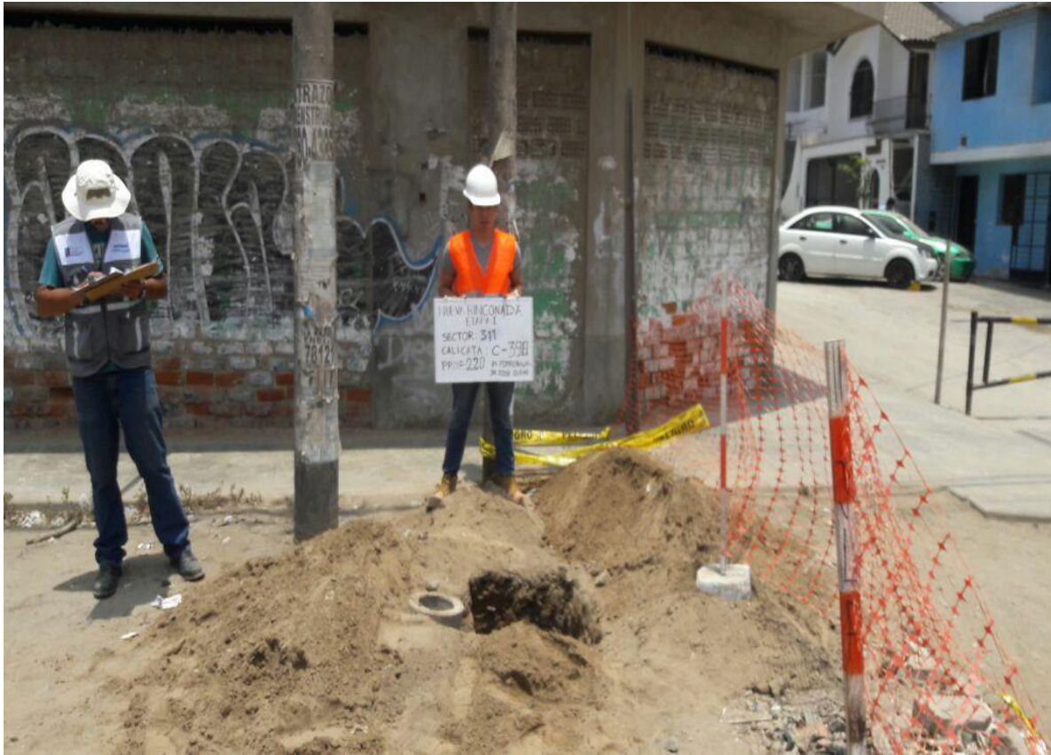
Ilustración 26. Calicata para estudio de suelos para ejecución de Método Cracking.
