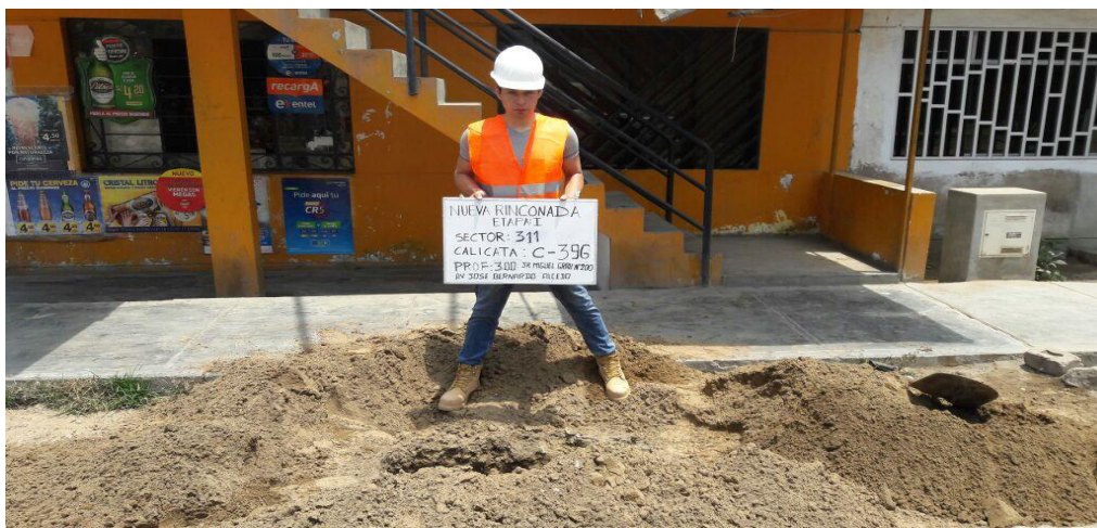
Ilustración 24. Calicata para estudio de suelos para ejecución de método cracking.
