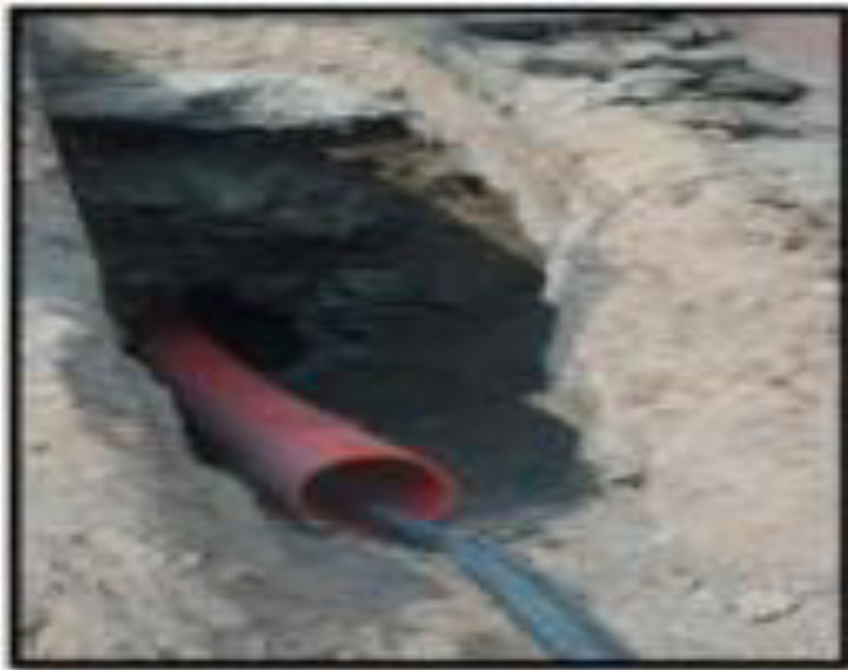
Ilustración 11. Entrada del tubo HDPE con 8” en uno de los ingresos.
