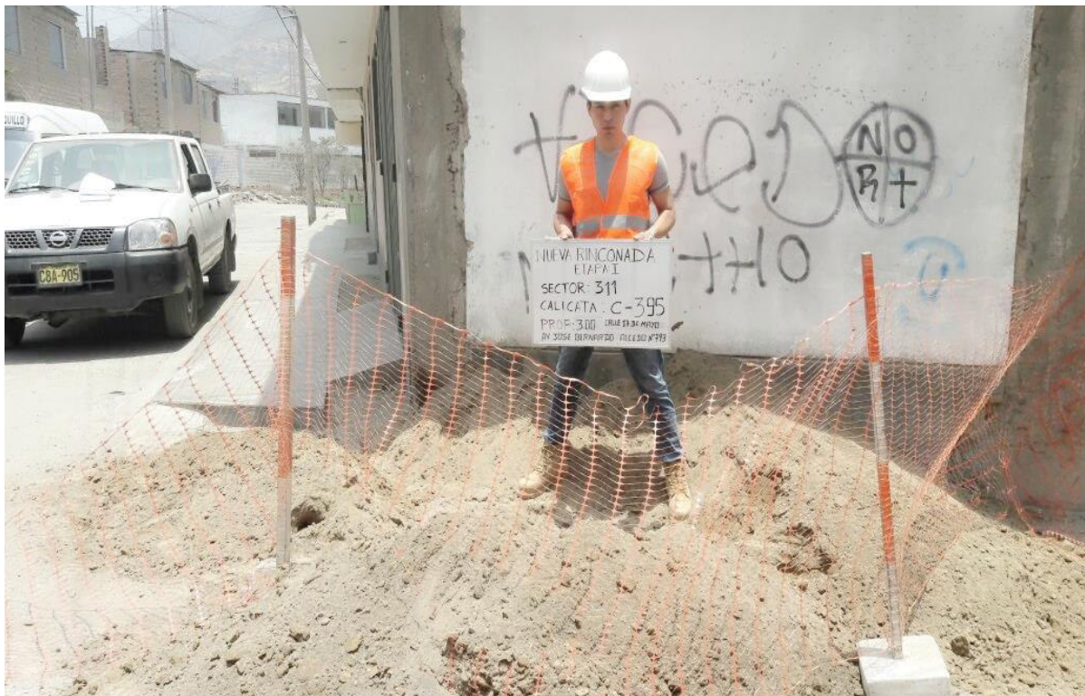
Ilustración 23. Calicata para estudio de suelos para ejecución de Método Cracking.
