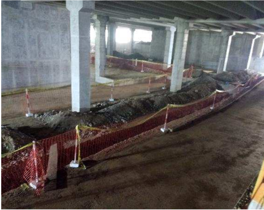
Ilustración 20. Relleno y compactación de zanja Fuente: Propia
