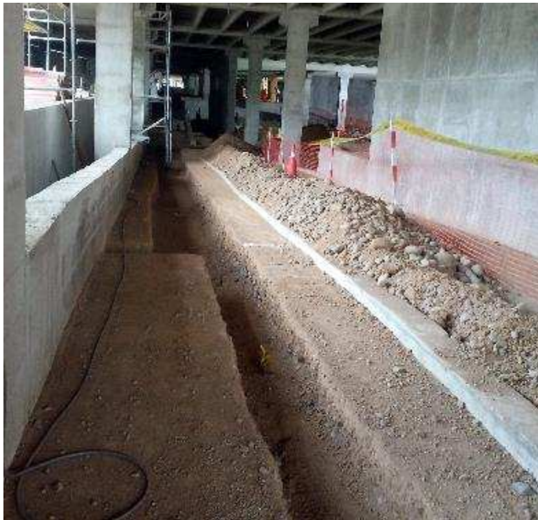
Ilustración 19. Actividad de excavación de zanja
