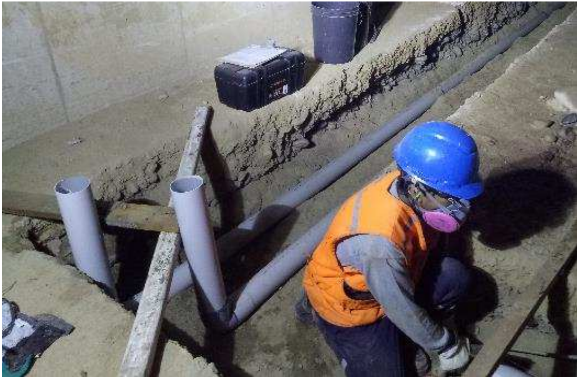
Ilustración 26. Prueba de estanqueidad Fuente: Propia
