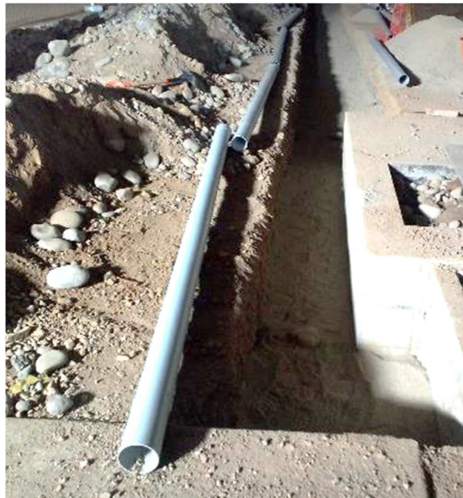
Ilustración 21. Instalación de tubería Fuente: Propia
