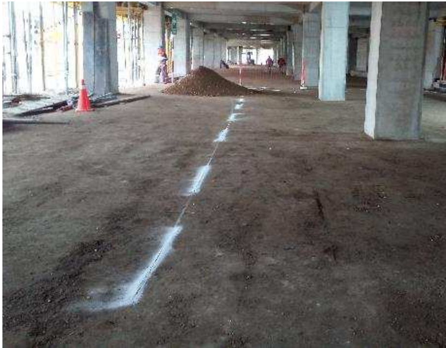
Ilustración 18. Actividad de trazo y replanteo
