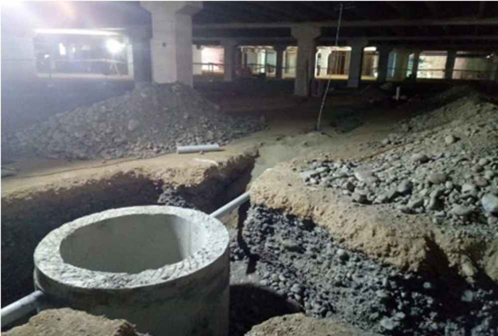
Ilustración 22. Picado y resane de muros, losa de fondo y media caña en buzón. Fuente: Propia
