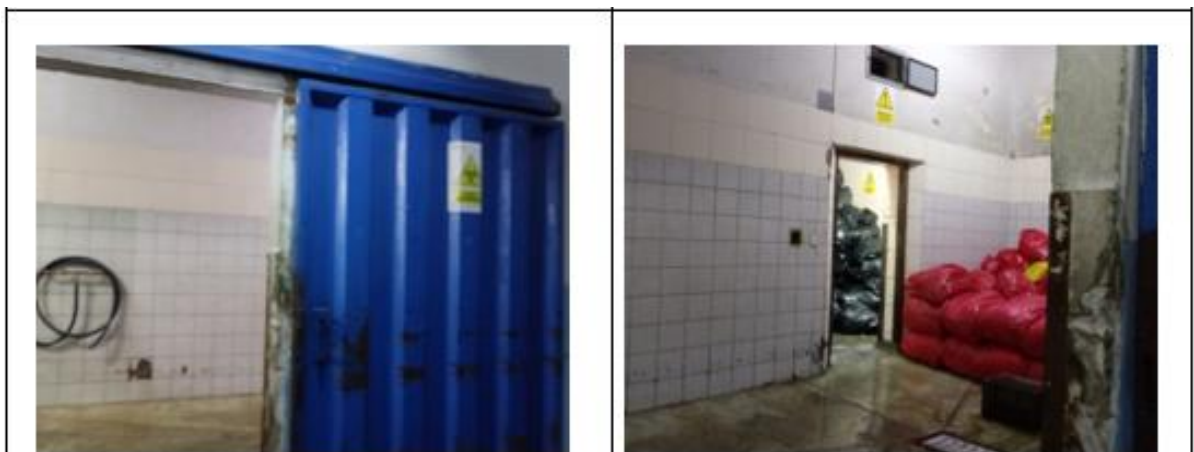
Figura 39. Área del Depósito final señalizada y Divisiones del depósito final para las clases de residuos sólidos Fuente: Elaboración propia
