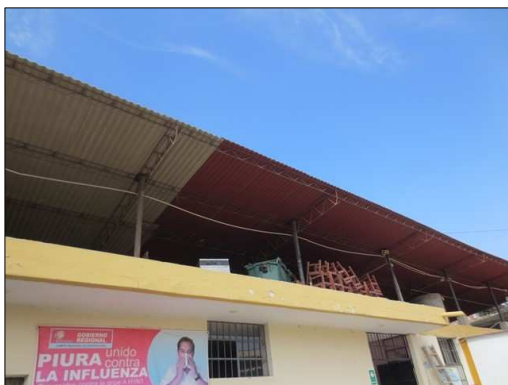
Depósito de materiales ubicado en techo Centro Obstétrico
