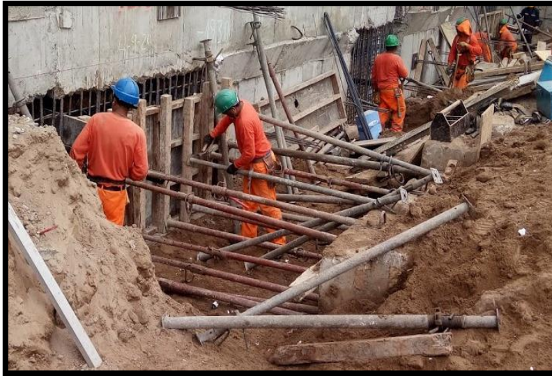
Figura 25: Refuerzos de dados de concreto en el encofrado.
