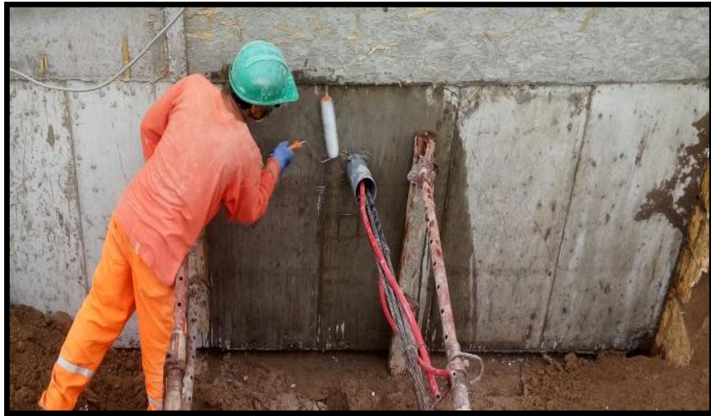
Figura 13: Curado de muro C.C. la Molina
