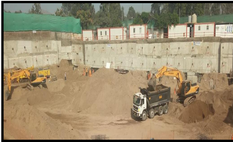
Figura 4: Excavación masiva proyecto C.C. la Molina
