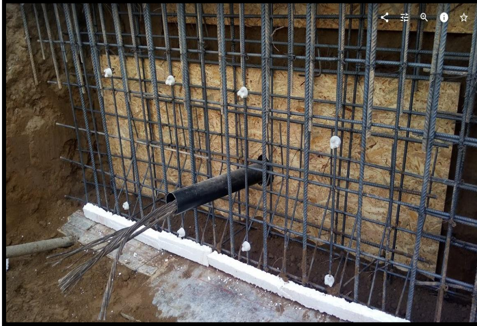
Figura 8: Acero ya instalado, mechas enterradas C.C. La Molina.
