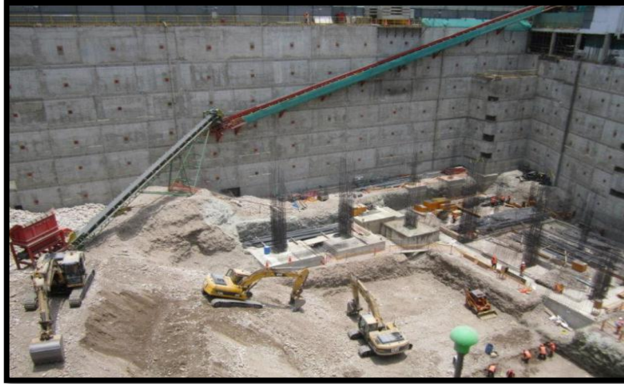
Figura 58: Uso de fajas transportadoras para la eliminación de material.
