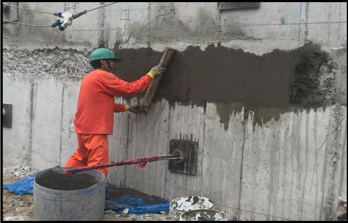
Figura 67: Resane después de desencofrado.
