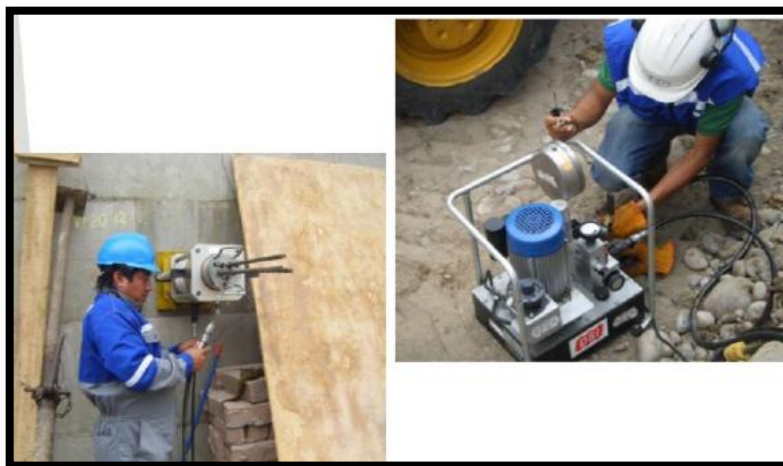
Figura 15: Tensado de anclajes
