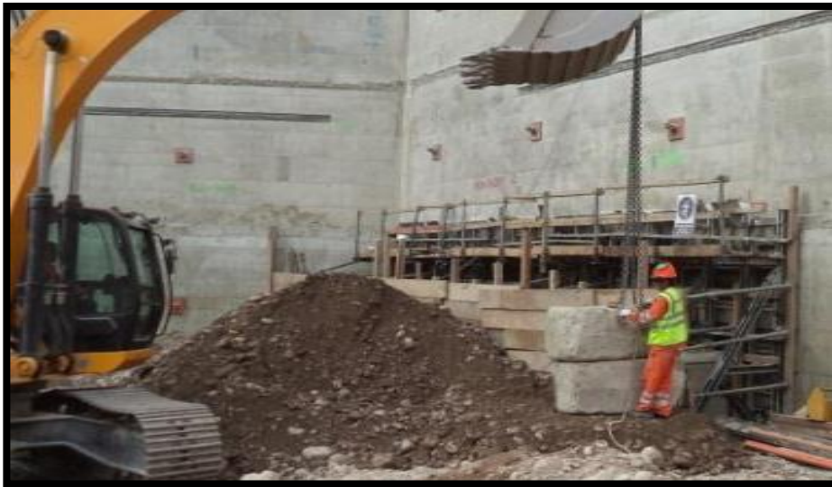
Figura 12: Desencofrado usando una excavadora para movilizar los dados de concreto C.C. la Molina.
