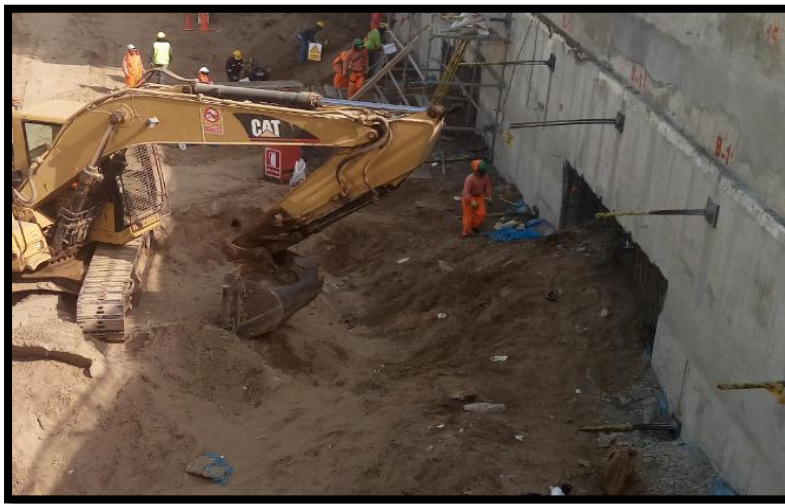
Figura 7: Excavación de banquetas C.C. la Molina.
