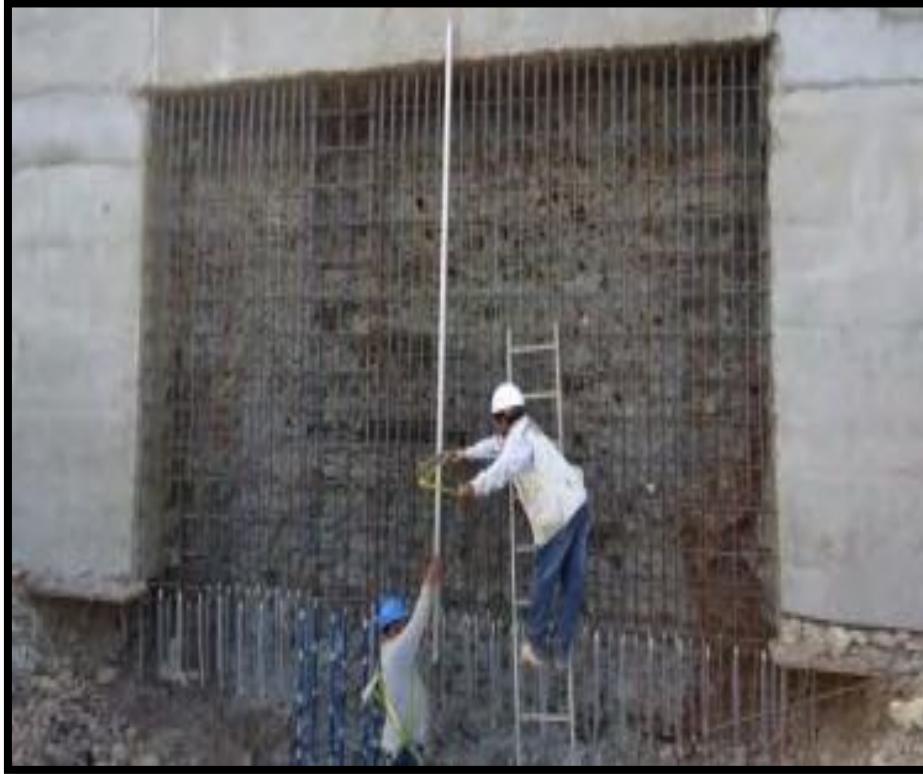
Figura 51: Protección del acero en obra.
