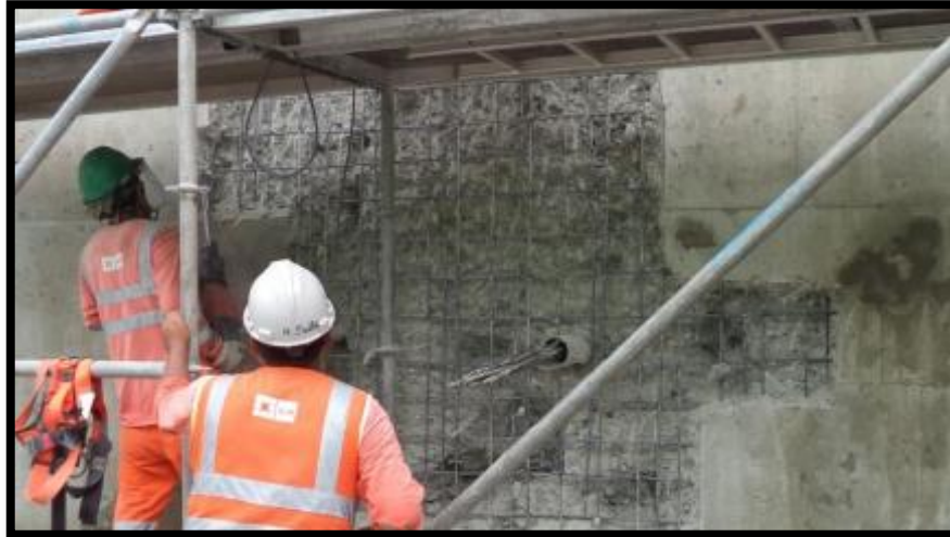
Figura 28: Demolición de muro
