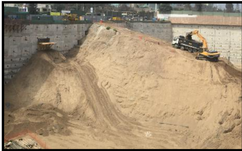
Figura 56: Muros atrapados en zona de rampa.
