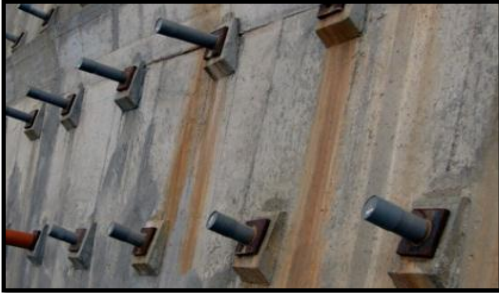
Figura 66: Placa metálica instalada en diagonal.
