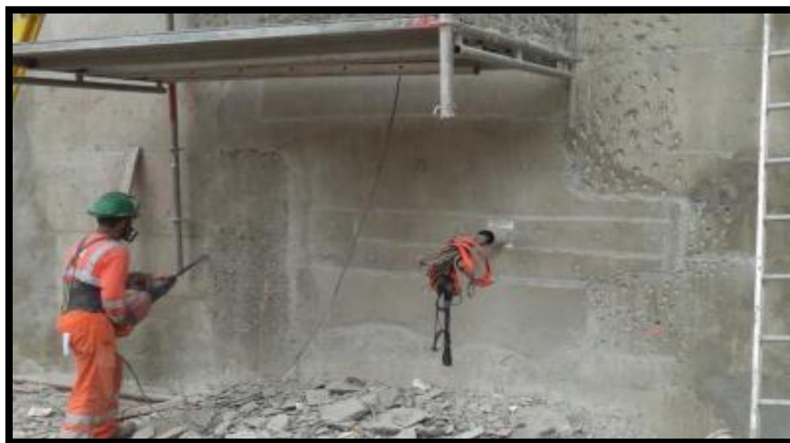
Figura 29: Reparación de muro
