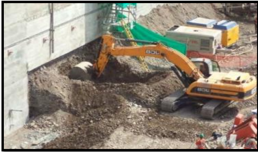
Figura 64: Excavación de paños consecutivos.
