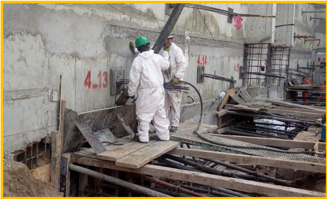
Figura 11: Vaciado de muro C.C. la Molina.
