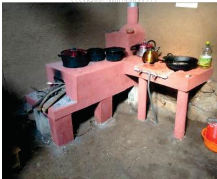
Foto 13: Estructura Cocina mejorada
