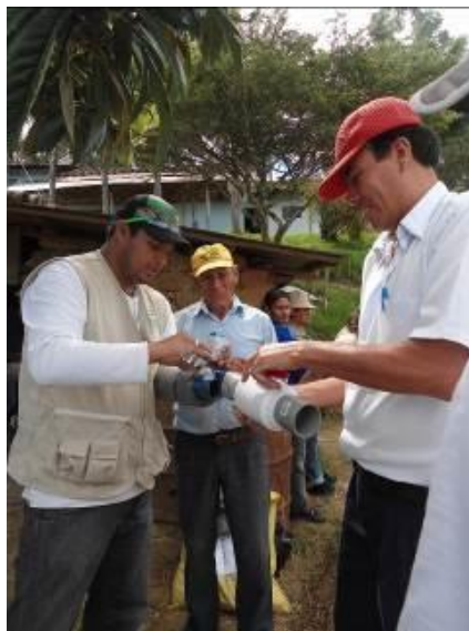
Foto 7: Instalación de salida de sólidos
