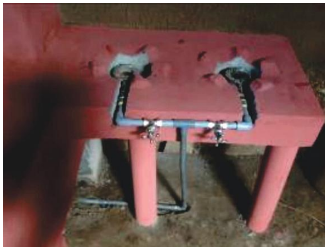
Foto 16: Instalación de accesorios cocina mejorada
