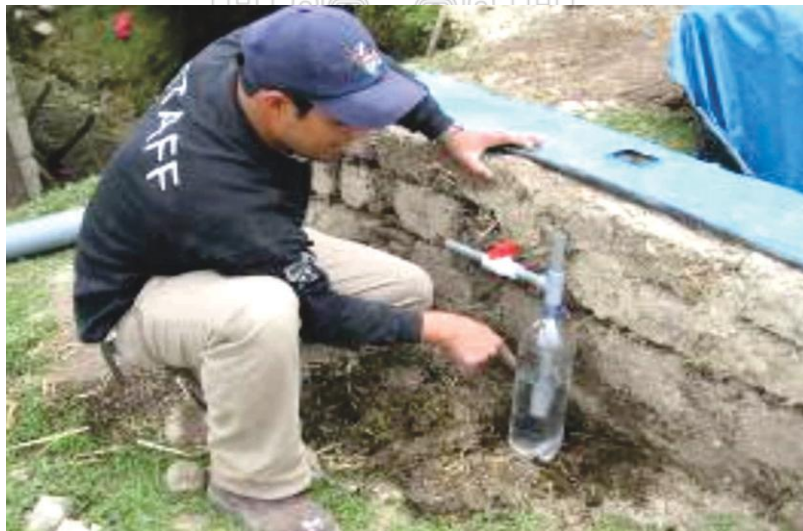
Foto 15: Instalación de válvula de seguridad
