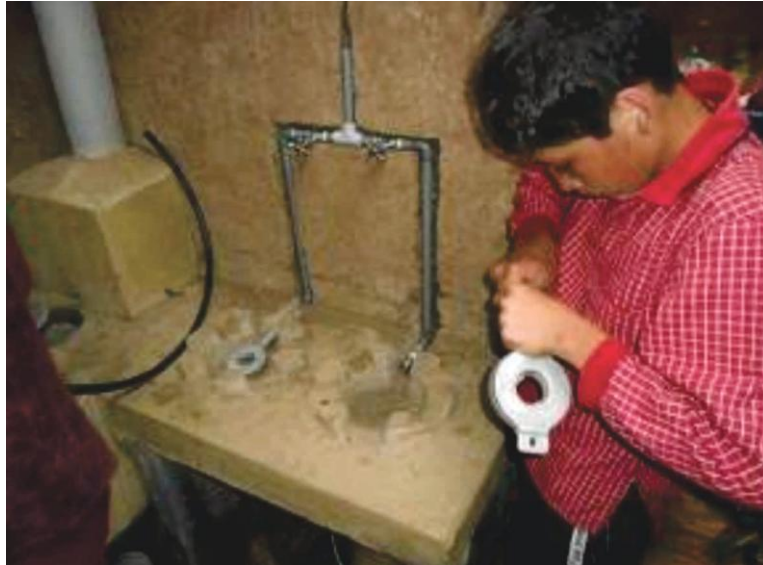
Foto 14: Instalación de conexiones
