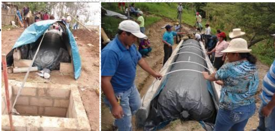
Foto 6: Nivelación de tuberías de E/S
