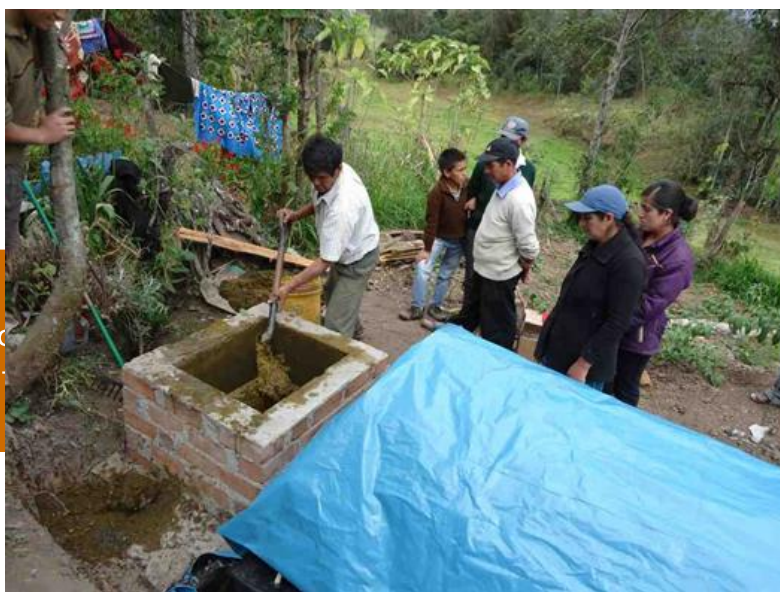
Foto 12: Mantenimiento del biodigestor
