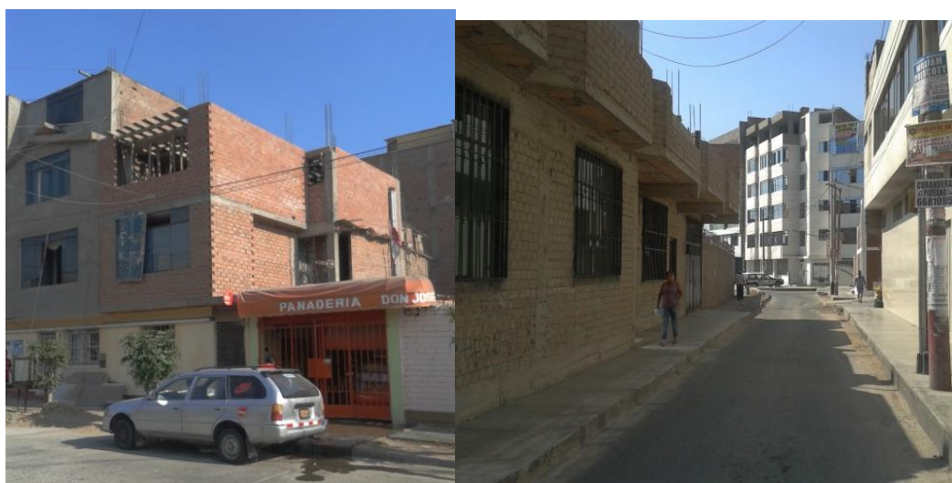
Vivienda mal construida cerca de la avenida José Granda (izquierda), alero de vivienda ocupa vía pública cerca de avenida Izaguirre (derecha). Distrito de San Martín de Porres, 2015.
