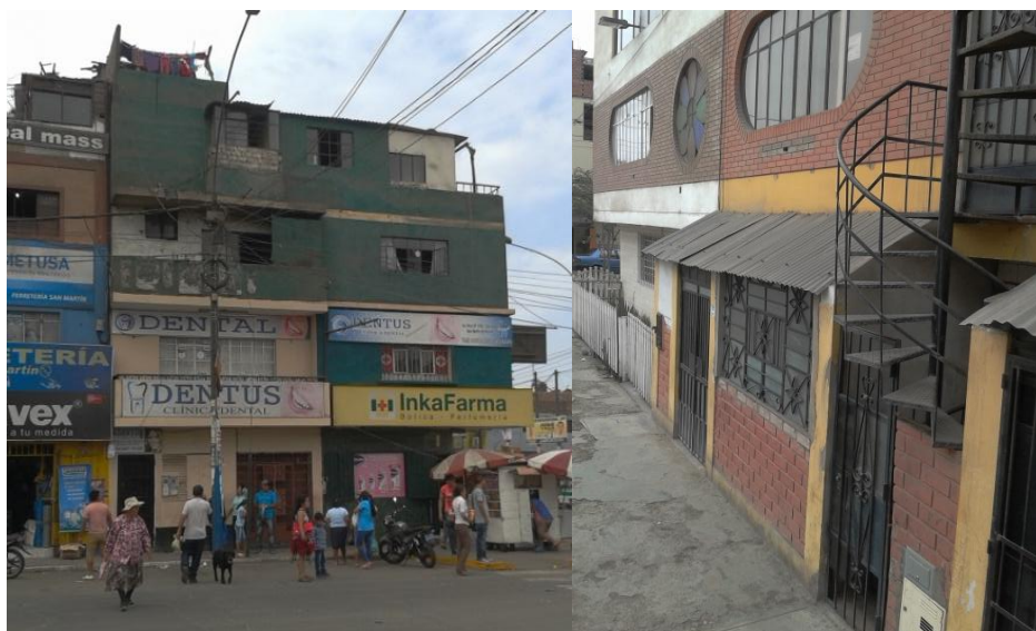
Vivienda mal construida en avenida Perú (izquierda), escalera de vivienda ocupando vía pública al lado de puente Honorio Delgado (derecha). Distrito de San Martín de Porres, 2015.
