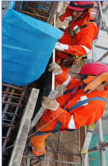
Colocación de laterales de viga sobre escuadras
