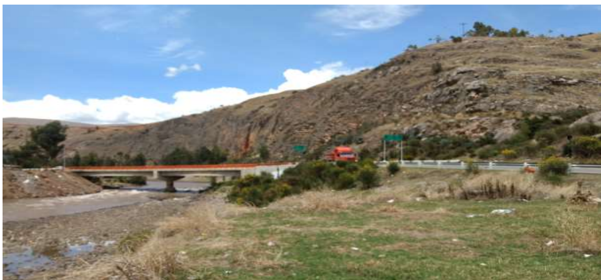
Fotografía 2. Puente Stuard, Carretera Central km 260
