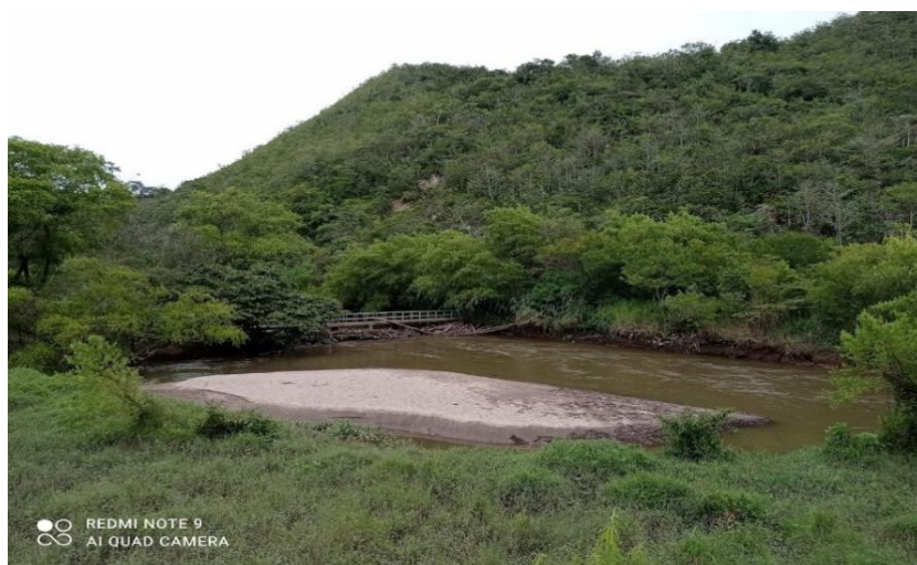
Retención de palizadas en la cuenca baja
