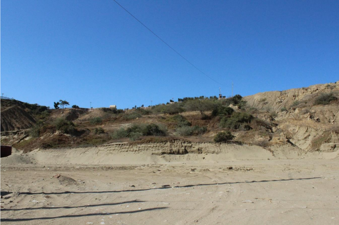
Vista Frontal Acercamiento desde carretera
