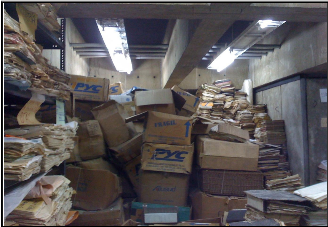
Figura N° 03.- Documentación afectada por humedad, microorganismos.
