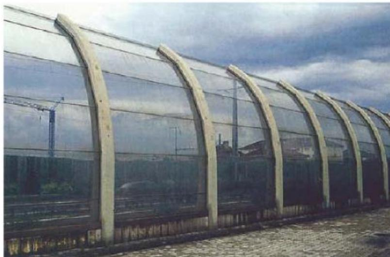
Figura 12. Barrera acústica de acrílico. Tomado de KOTZEN, Benz. 1999. Environmental Noise Barrier. E & FN Spum. Pagina 121.
