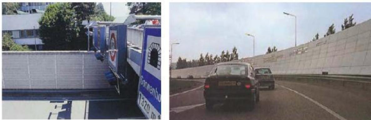
Figura 8. Barrera acústica de lámina metálica. Tomado de KOTZEN, Benz. 1999. Environmental Noise Barrier. E & FN Spum. Pagina 113.
