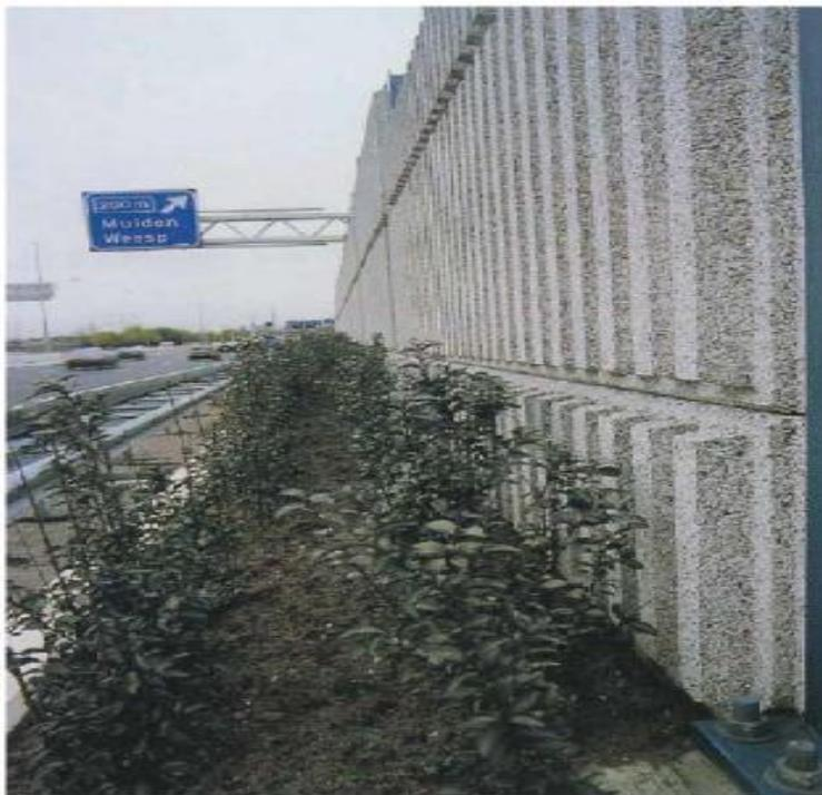
Figura 10. Barrera acústica de concreto absorbente. Tomado de KOTZEN, Benz. 1999. Environmental Noise Barrier. E & FN Spum. Pagina 118.
