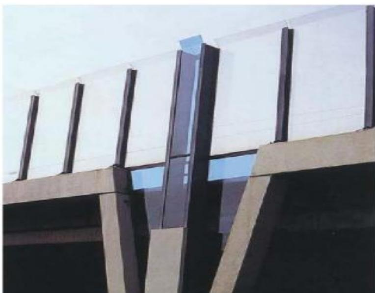
Figura 11. Barrera acústica de PVC. Tomado de KOTZEN, Benz. 1999. Environmental Noise Barrier. E & FN Spum. Pagina 121.
