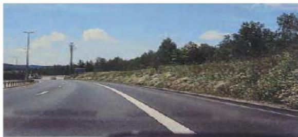
Figura 5. Barrera acústica tipo talud. Tomado de KOTZEN, Benz. 1999. Environmental Noise Barrier. E & FN Spum. Página 100.
